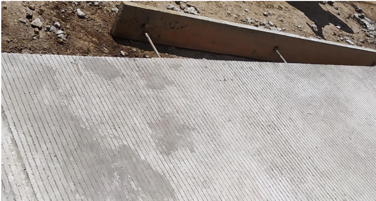
Imagen 2. Supervision de losas de concreto fundidas.
