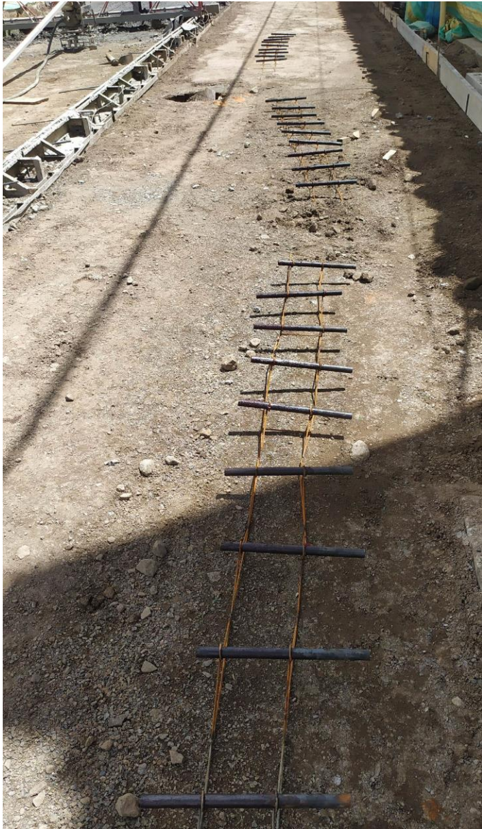
Imagen 1. Supervisión de los pasadores longitudinales y formaleta.
