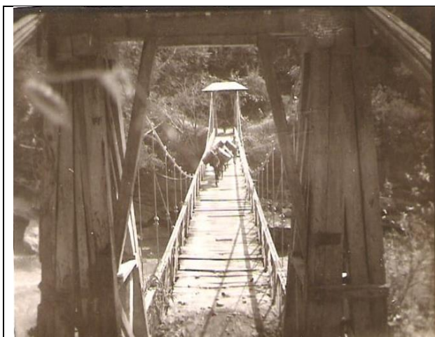
Foto 17. Puente Juan de la Cruz Posada en 1900. Fuente: Ituango_blogspot.com
