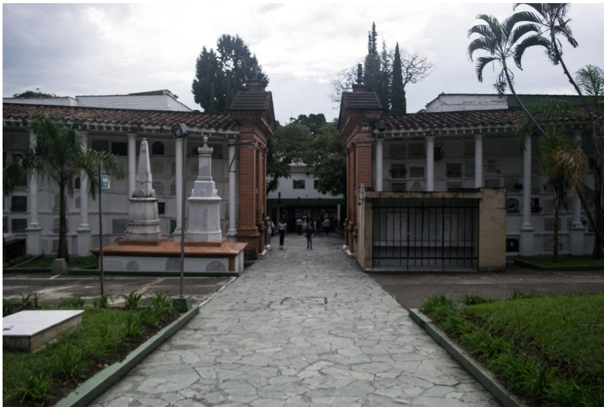
Fotografía 2. Corredor patio central, CMSP. Archivo personal, 2018.
