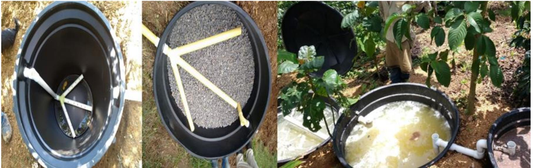
Figura 18. Tanque con Filtro Anaeróbico de Flujo Ascendente FAFA
