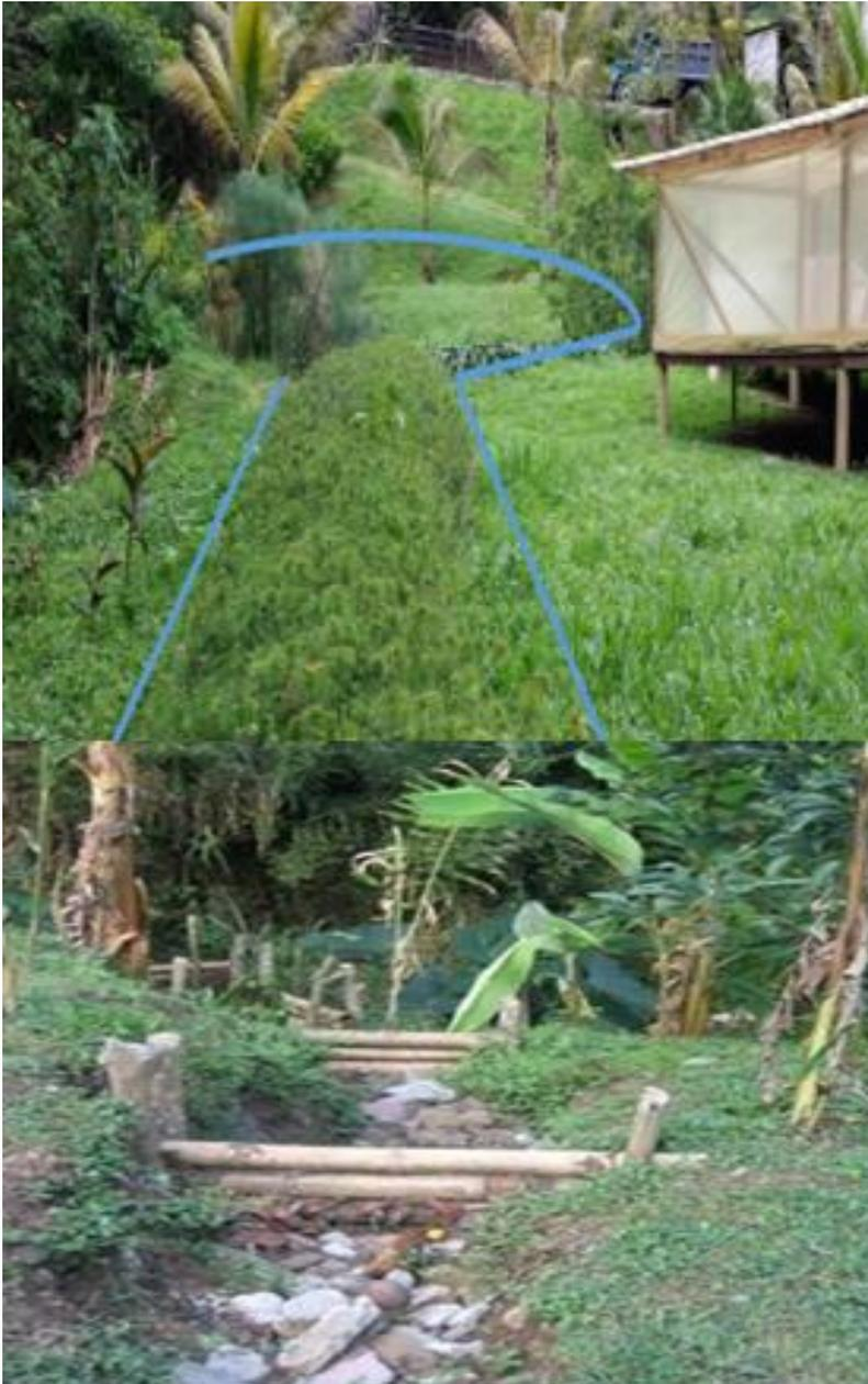
Figura 19. Zanja de infiltración
