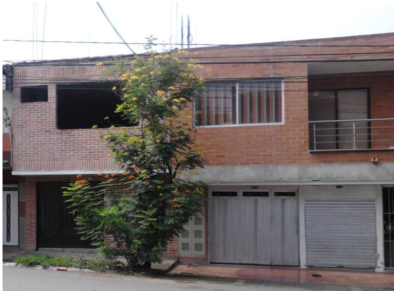
Etapas finales de la construcción
