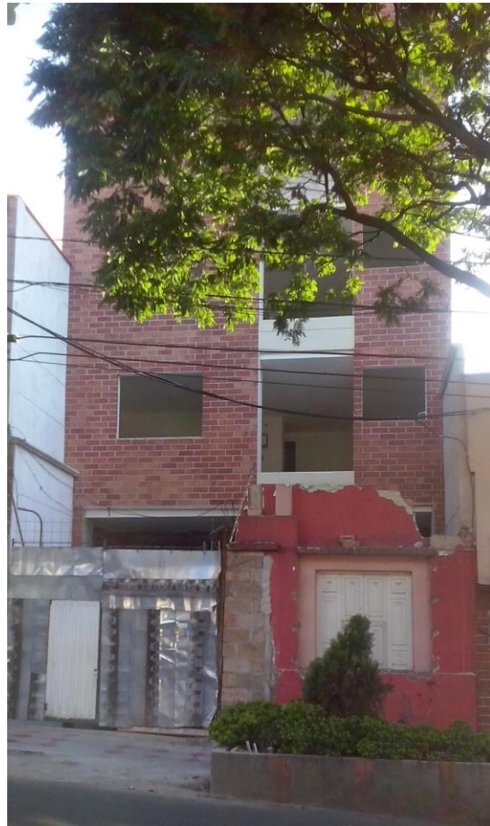
Casa antigua demolida para construcción edificio de apartamentos. 2014.
