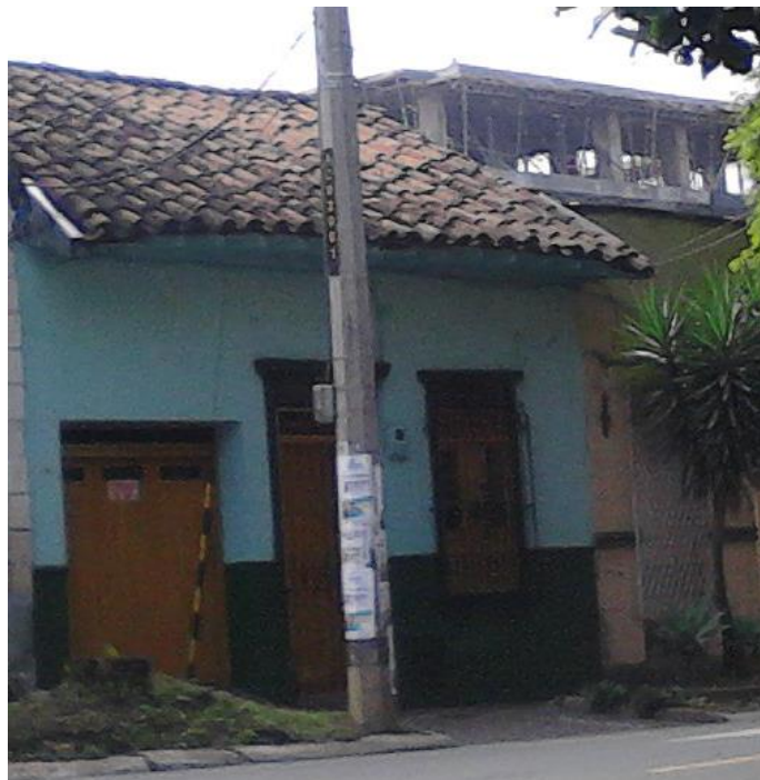
Casa ubicada en la carrera 36 con cl 55, al fondo se erige una construcción en altura.
