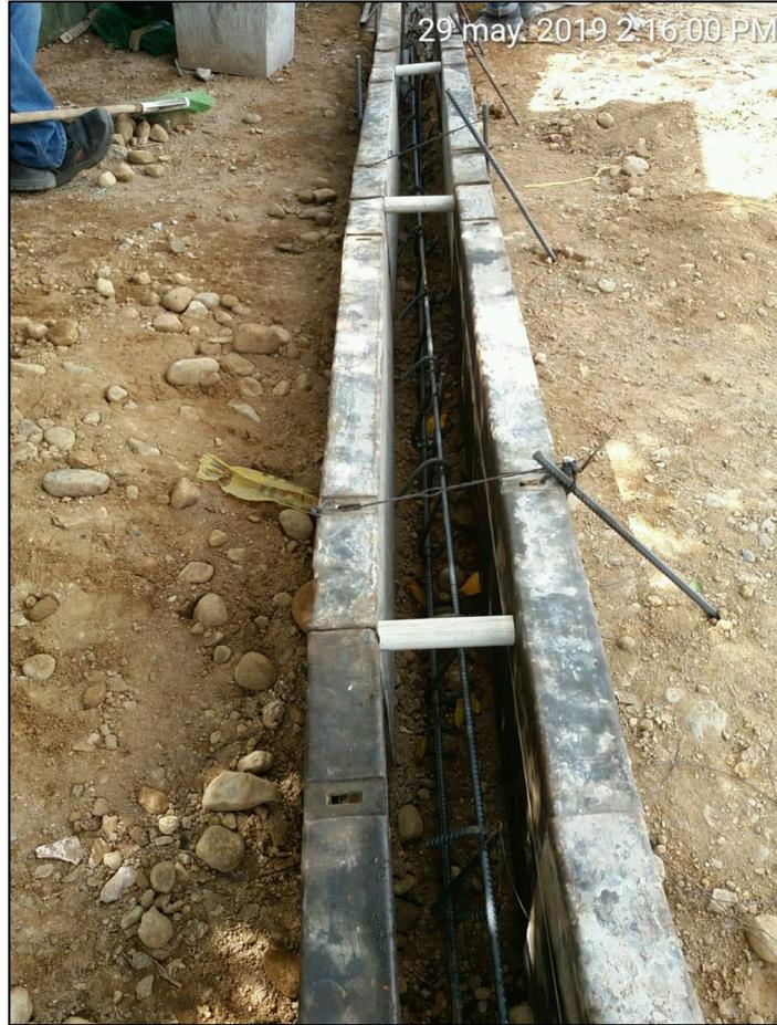
*Imagen 17. Acero de refuerzo para bordillo vial. -OBRA DE AMPLIACIÓN GLORIETA LA CEIBA*
