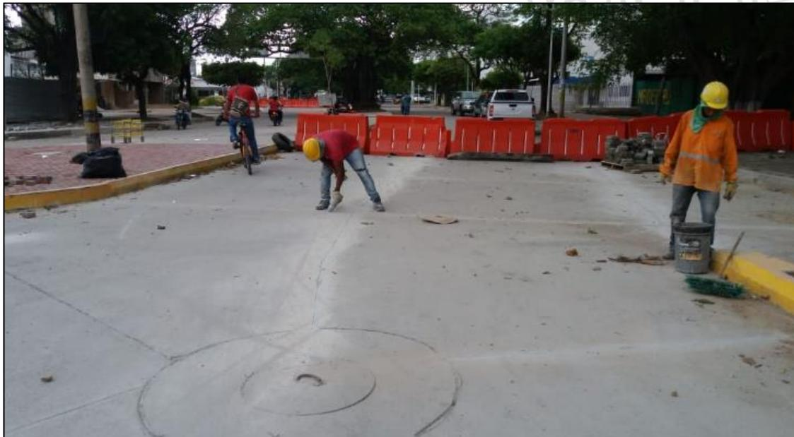
*Imagen 24. Aplicación de sello en juntas de losas de concreto. -OBRA DE AMPLIACIÓN GLORIETA LA CEIBA*
