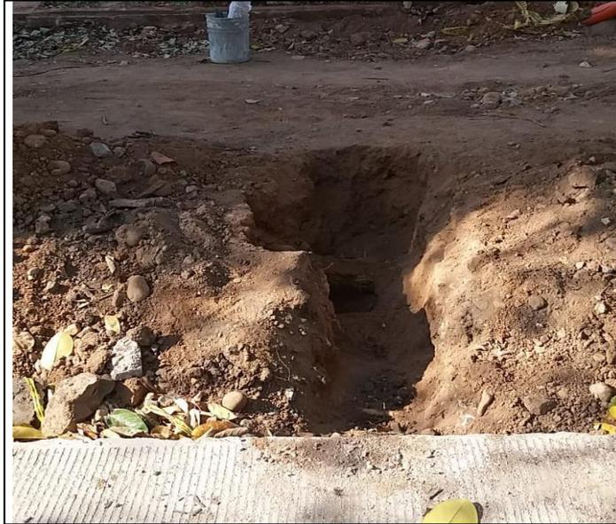
*Imagen 7. Excavación para exploración por apique -OBRA DE AMPLIACIÓN GLORIETA LA CEIBA*
