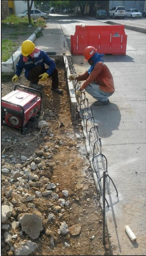
*Imagen 29. Formateada de bordillo vial. -OBRA DE AMPLIACIÓN GLORIETA LA CEIBA*
