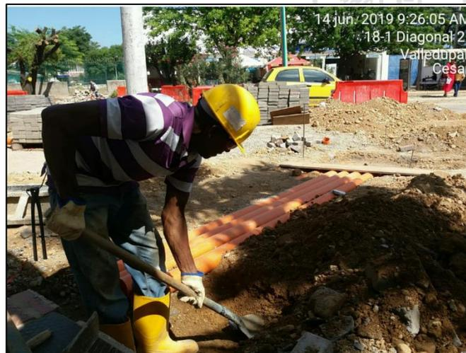
*Imagen 8. Excavación para instalación de tuberías -OBRA DE AMPLIACIÓN GLORIETA LA CEIBA*
