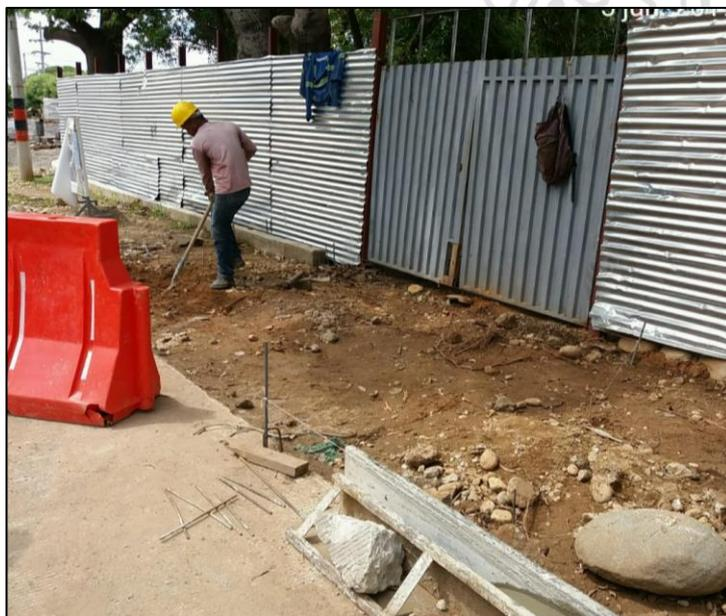
*Imagen 10. Excavación para construcción andén peatonal -OBRA DE AMPLIACIÓN GLORIETA LA CEIBA*
