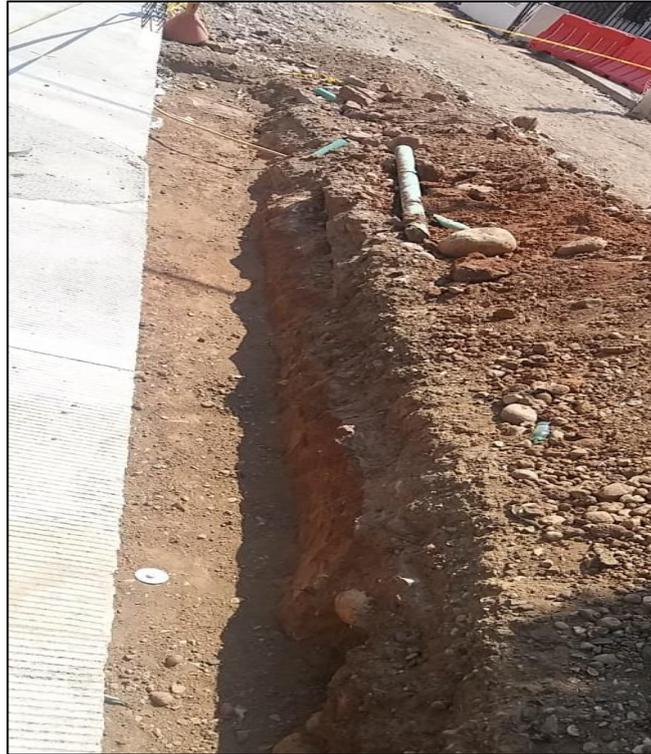
*Imagen 9. Excavación para construcción de sumidero de agua lluvia -OBRA DE AMPLIACIÓN GLORIETA LA CEIBA*
