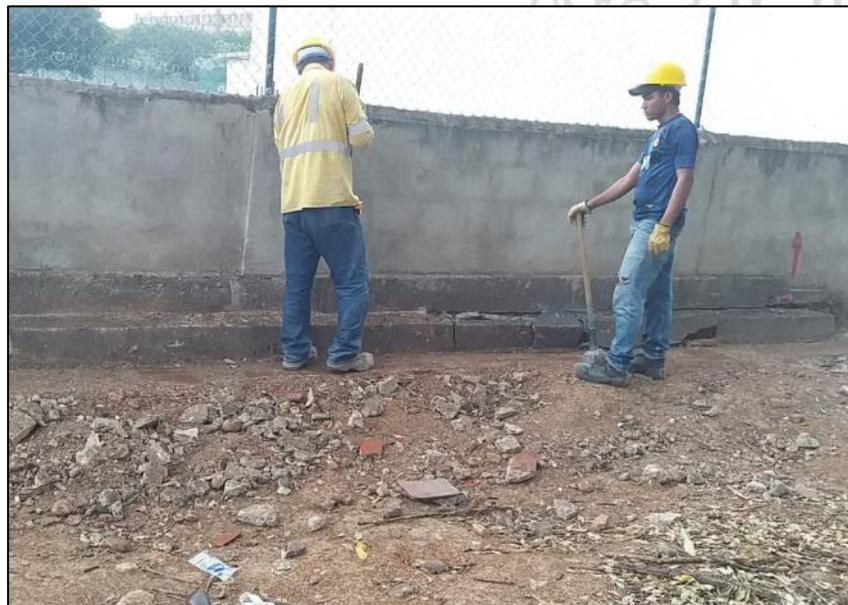
*Imagen 13. Demolición manual de bordillo. -OBRA DE AMPLIACIÓN GLORIETA LA CEIBA*
