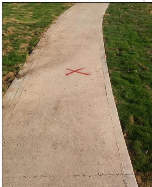
*Imagen 11. Plantilla de andén peatonal marcada para demolición debido a fractura. -OBRA DE AMPLIACIÓN GLORIETA LA CEIBA*
