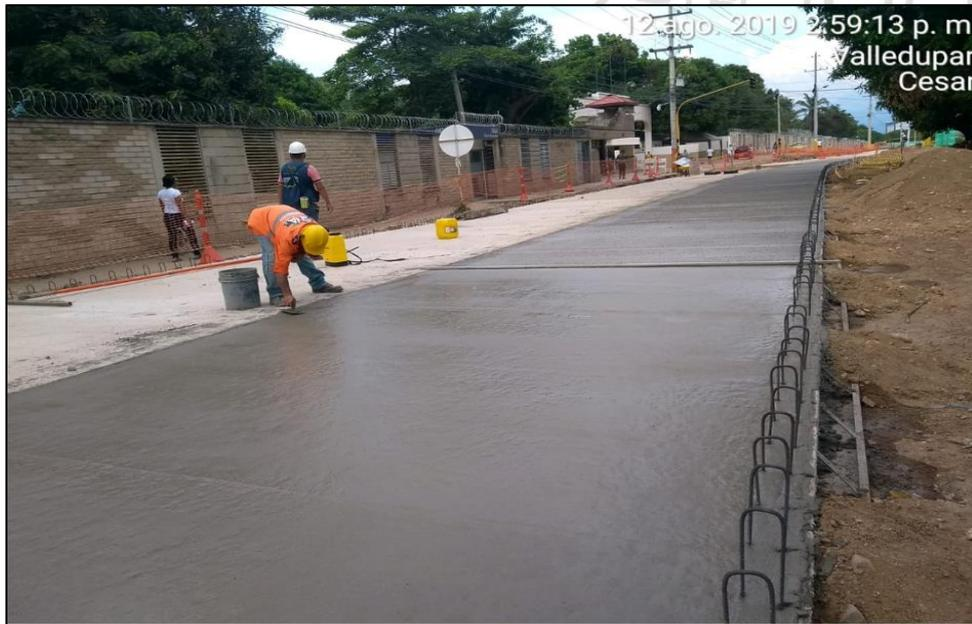
Imagen 21. Acabado para placas de concreto. -OBRA DE AMPLIACIÓN GLORIETA LA CEIBA
