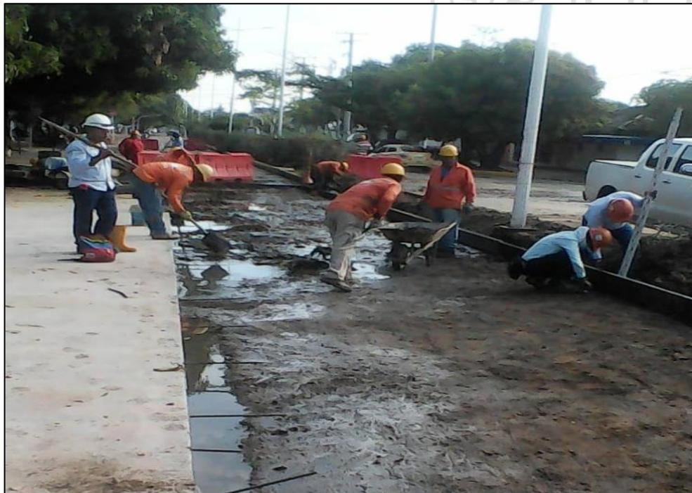
*Imagen 6. Imprevisto, terreno a fundir saturado -OBRA DE AMPLIACIÓN GLORIETA LA CEIBA*
