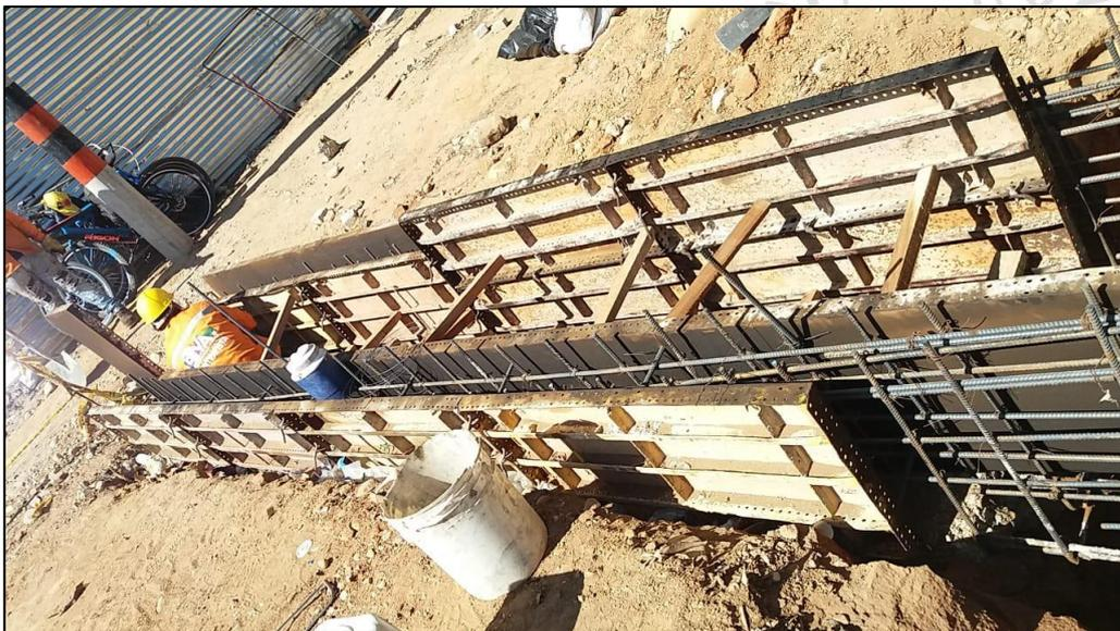
*Imagen 14. Acero de refuerzo para sumidero de agua lluvia. -OBRA DE AMPLIACIÓN GLORIETA LA CEIBA*
