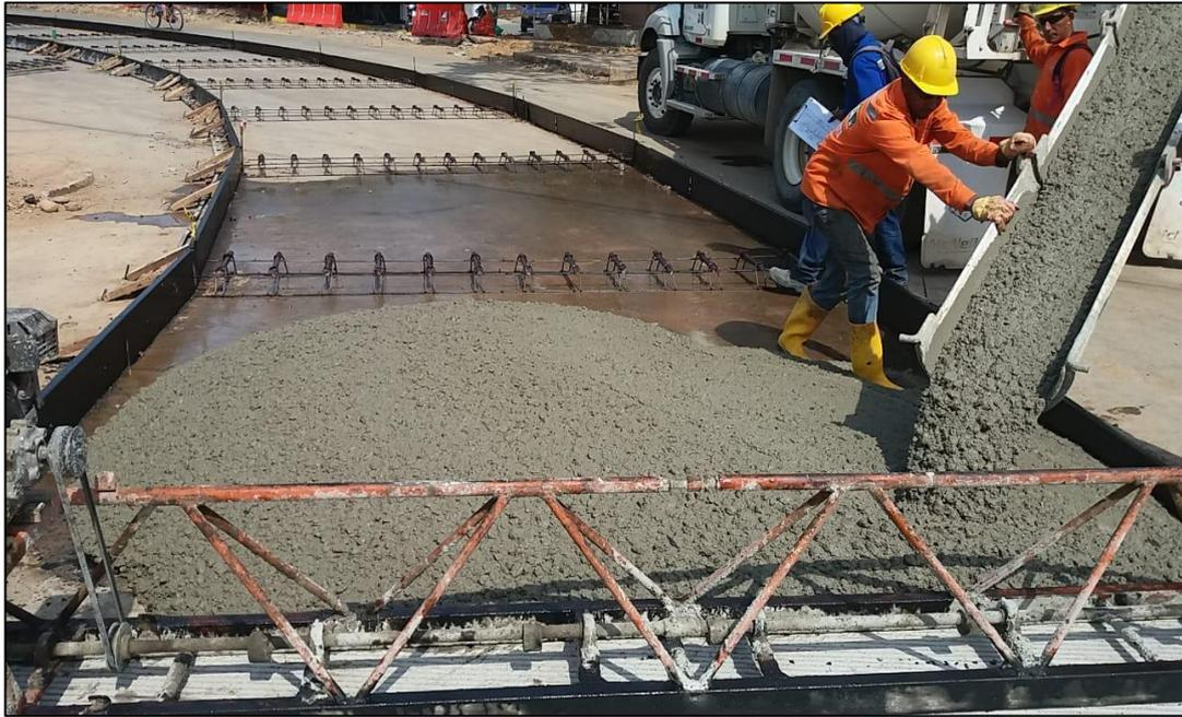
Imagen 20. Actividad de fundida de losas de concreto. -OBRA DE AMPLIACIÓN GLORIETA LA CEIBA
