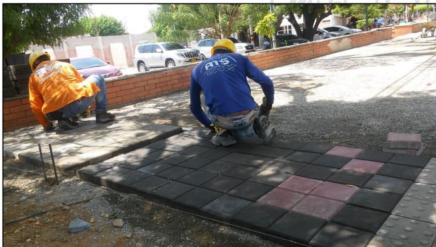
*Imagen 38. Instalación de adoquín para tráfico peatonal. -OBRA DE AMPLIACIÓN GLORIETA LA CEIBA*
