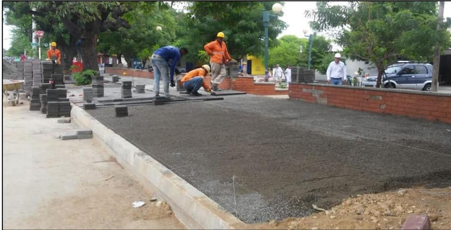
*Imagen 37. Extendida de arena base. -OBRA DE AMPLIACIÓN GLORIETA LA CEIBA*
