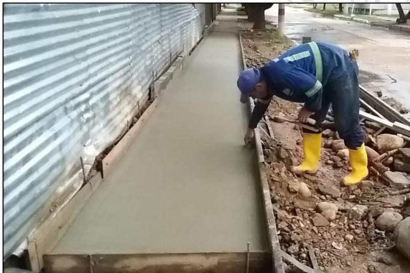
Imagen 34. Fundida y acabado de anden peatonal. -OBRA DE AMPLIACIÓN GLORIETA LA CEIBA
