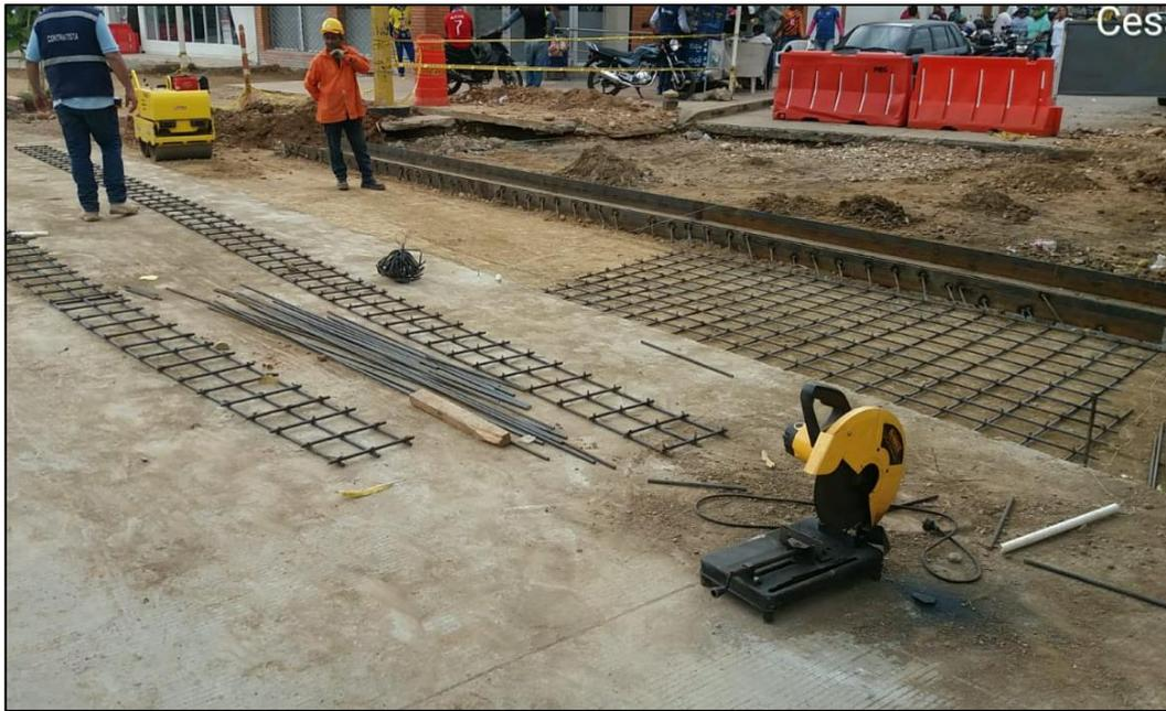
Imagen 15. Acero de refuerzo para placas de concreto cruce de calle. -OBRA DE AMPLIACIÓN GLORIETA LA CEIBA
