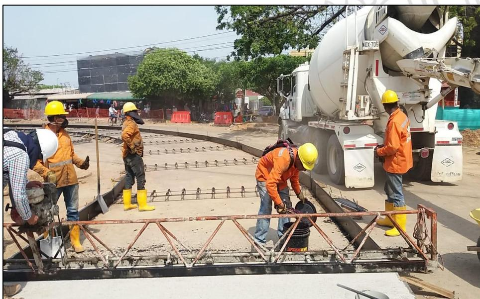
*Imagen 19. Preparativos fundida losa de concreto. -OBRA DE AMPLIACIÓN GLORIETA LA CEIBA*
