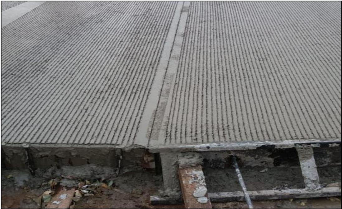
*Imagen 22. Rayado de placas de concreto. -OBRA DE AMPLIACIÓN GLORIETA LA CEIBA*
