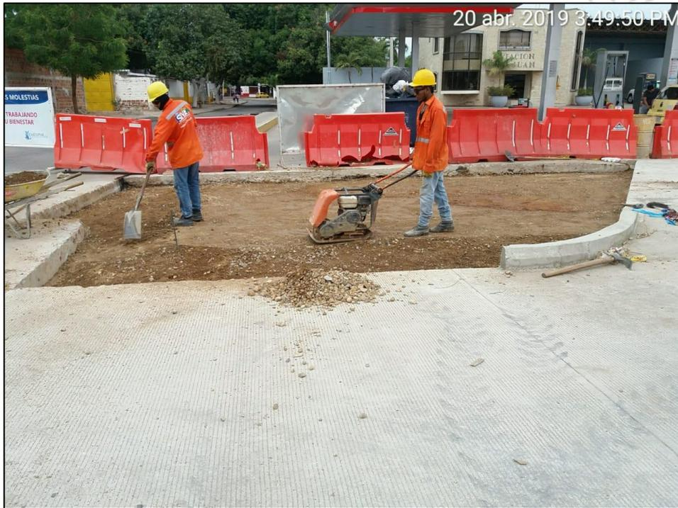
*Imagen 4. Compactación de terreno -OBRA DE AMPLIACIÓN GLORIETA LA CEIBA*
