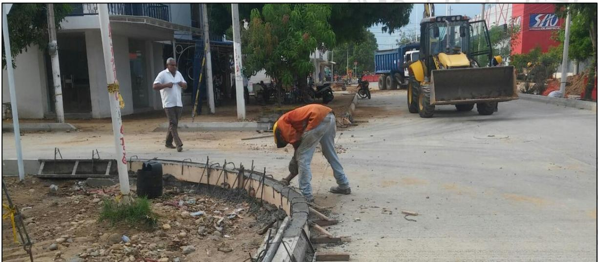
*Imagen 32. Acabado de bordillo vial. -OBRA DE AMPLIACIÓN GLORIETA LA CEIBA*
