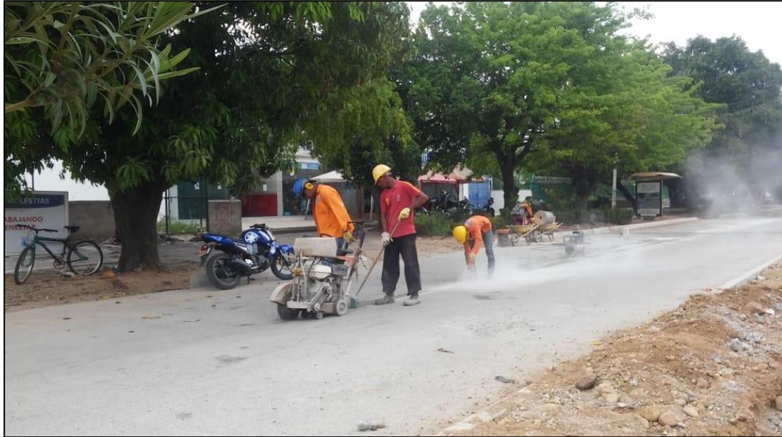
*Imagen 23. Corte en juntas de losas de concreto. -OBRA DE AMPLIACIÓN GLORIETA LA CEIBA*
