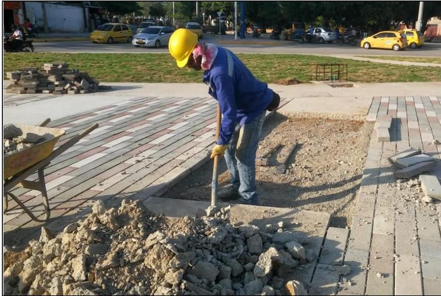
*Imagen 12. Cargue y retiro de escombros de plantilla de anden peatonal demolida. -OBRA DE AMPLIACIÓN GLORIETA LA CEIBA*
