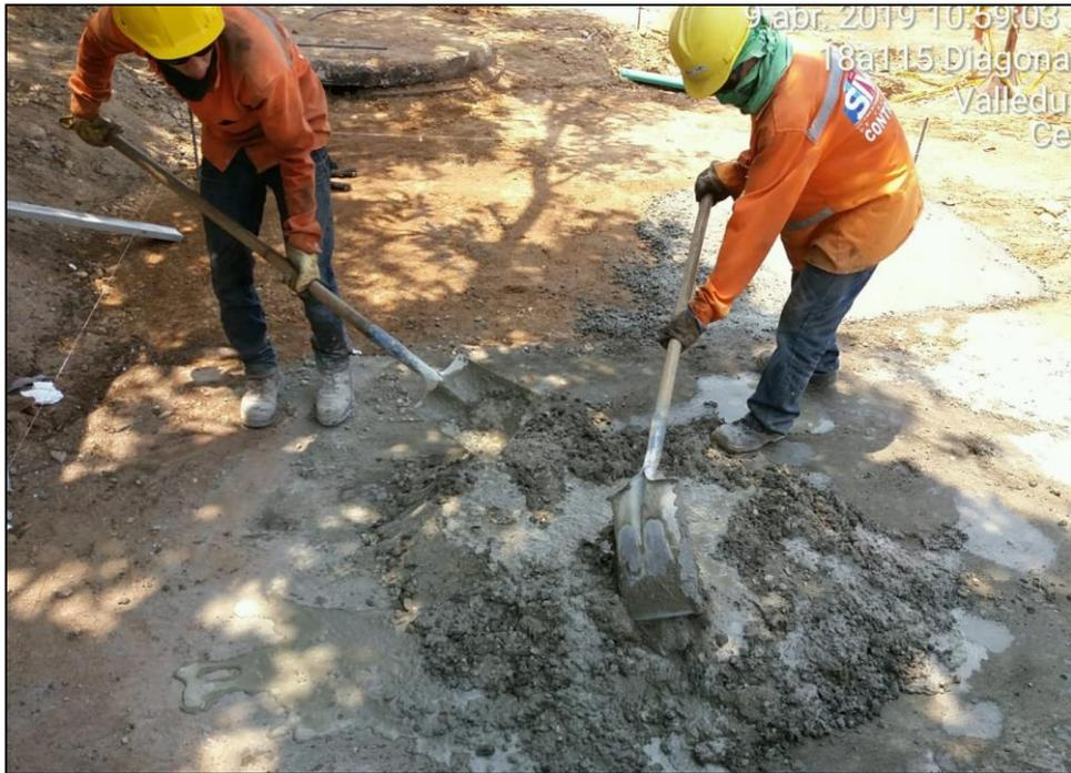
Imagen 35. Preparación concreto 1:2:3 para concreto solado. -OBRA DE AMPLIACIÓN GLORIETA LA CEIBA
