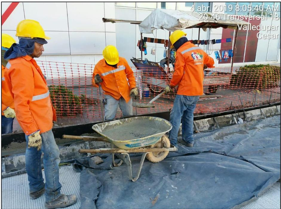
*Imagen 31. Fundida de bordillo vial. -OBRA DE AMPLIACIÓN GLORIETA LA CEIBA*
