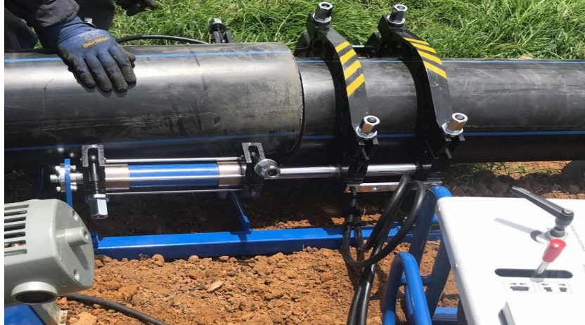
Imagen 3. Proceso de pegado por termofusión.
