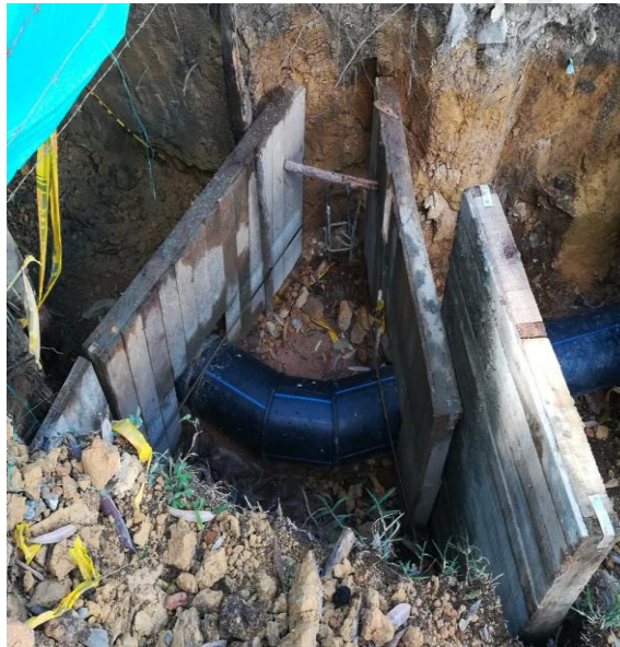
Imagen 17. Anclajes en accesorios.
