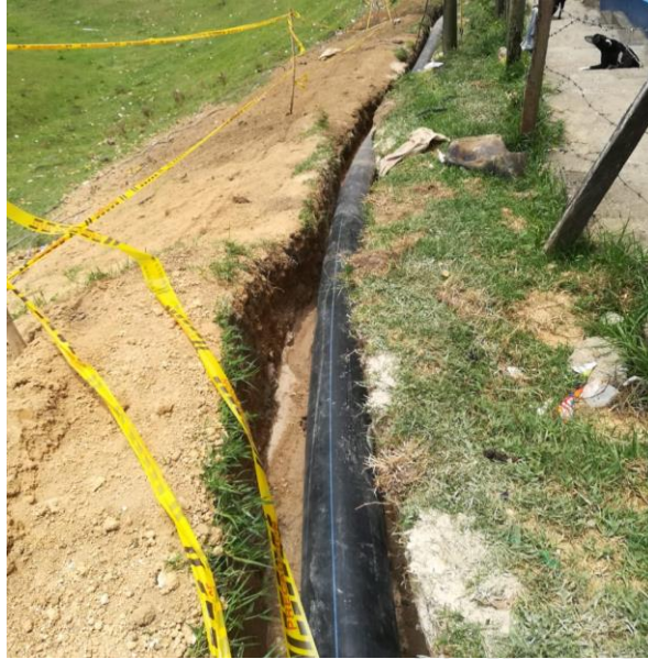
Imagen 18. Tramo tubería instalada.
