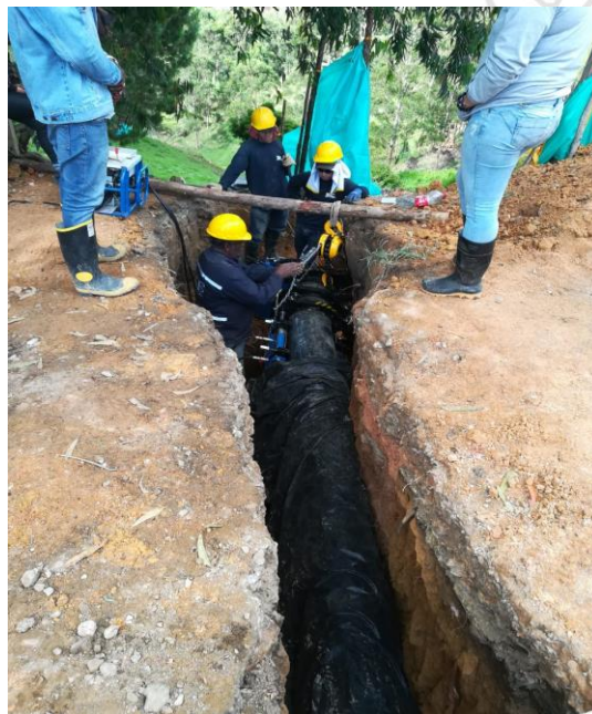
Imagen 15. Instalación de tubería sobre vía.
