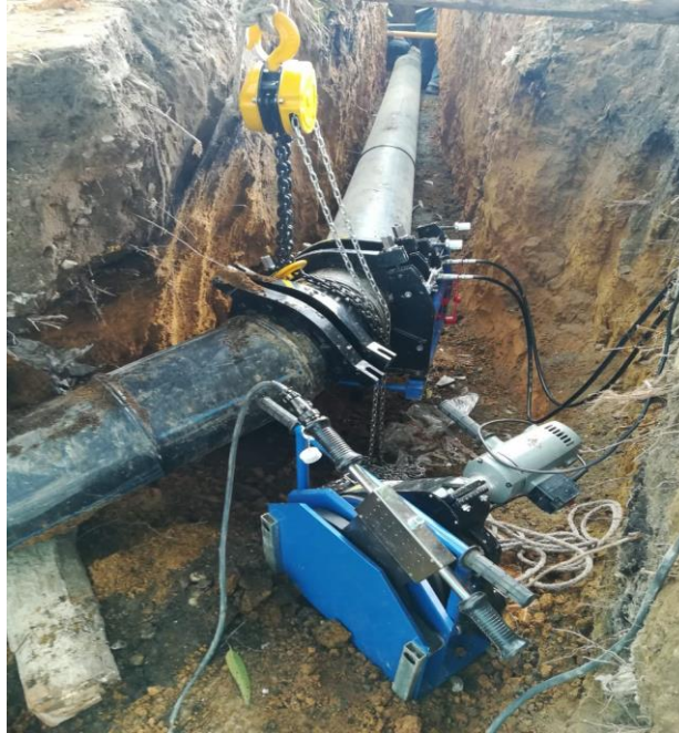
Imagen 16. Termofusión en codo.
