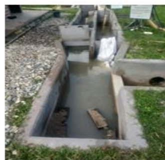
Imagen 10. Canal de entrada a) Sedimentación de material orgánico b) Instalación de ladrillos en el canal de entrada para aumentar la velocidad
