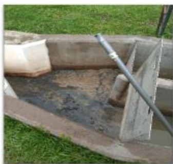
Imagen 10. Canal de entrada a) Sedimentación de material orgánico b) Instalación de ladrillos en el canal de entrada para aumentar la velocidad
