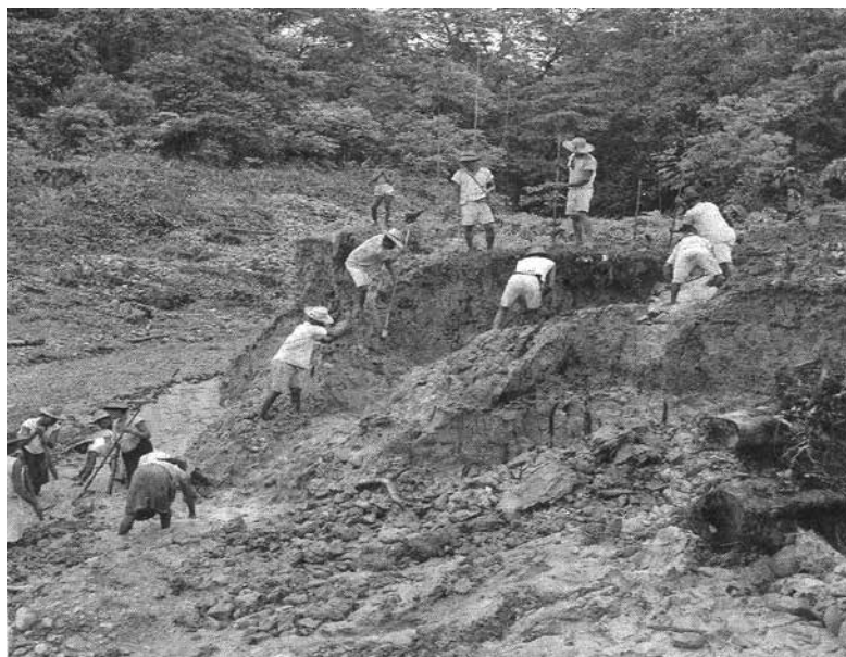
Figura 38. Canalón en interfluvio cerca del río Guelembí, Barbacoas. Hombres excavando el frente de la terraza con barras de hierro.
