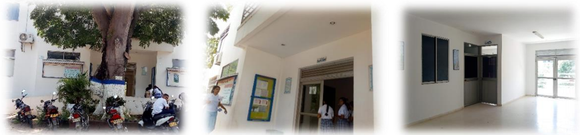
Figura 41. Bloque administrativo. Fuente: Registro fotográfico propio.
