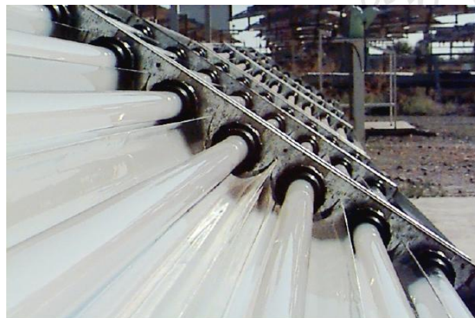
Figura 25. Representación de un compound parabolic collector.
