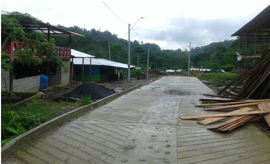
Foto 10. Vía San José de León (placa huella). Fuente: archivo del autor.
