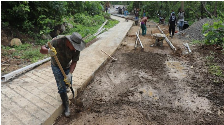
Foto 6. Trabajos en la vía de San José de León. Fuente: https://www.eltiempo.com
