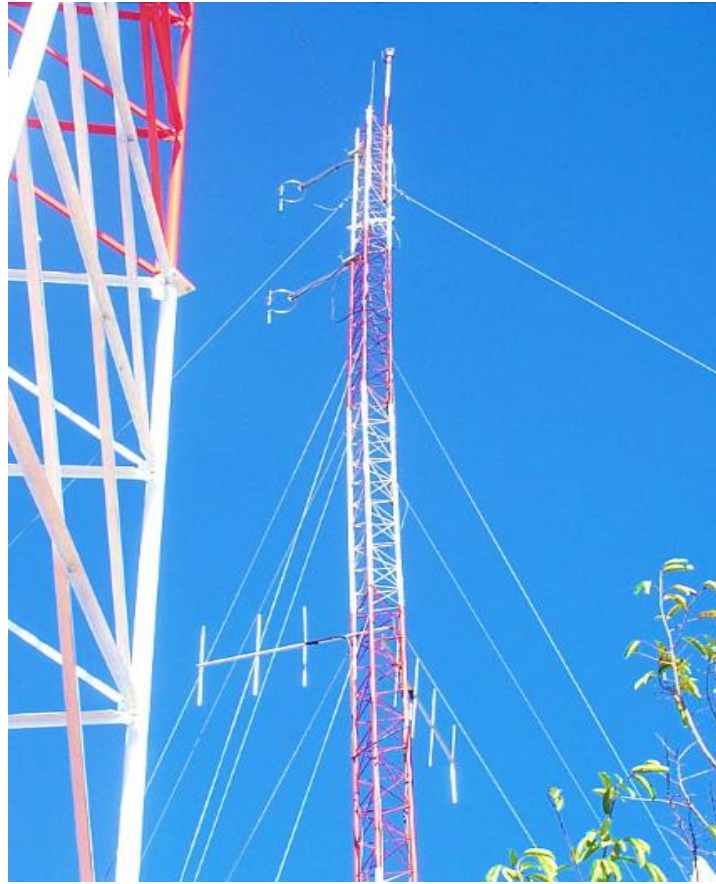
Imagen 7. Torre arriostrada o rendada. Tomado de: http://selecom.com.gt/wp-content/uploads/2018/01/torresarriostradas.jpg
