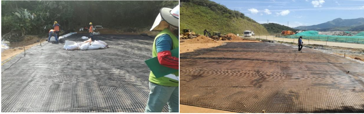
Imagen 6 Instalación de geomalla y costales
