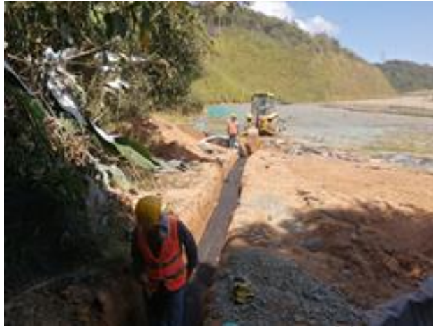
Imagen 2 Instalación de geotextil no tejido
