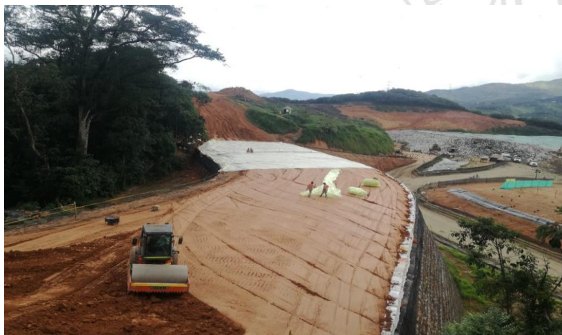
Imagen 14 Instalación de plásticos en el terraplén
