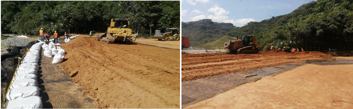
Imagen 10 Extendido de una capa de material
