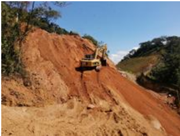
Imagen 9 Corte de talud
