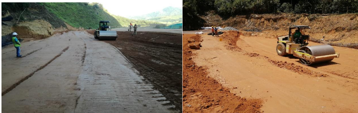
Imagen 11 Compactación de una capa de terraplén
