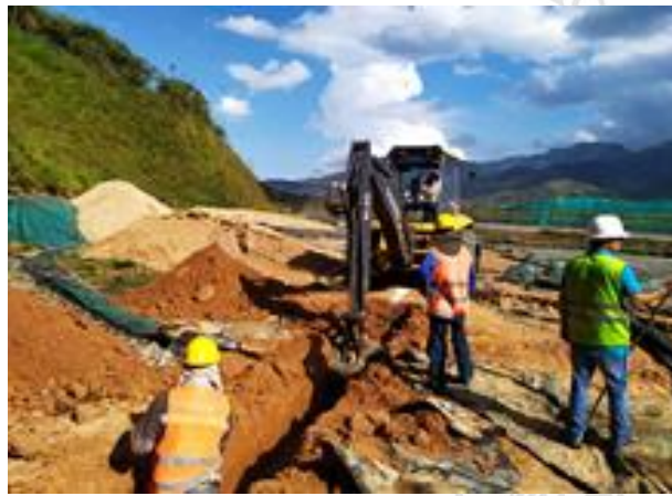
Imagen 1 Excavación para filtro
