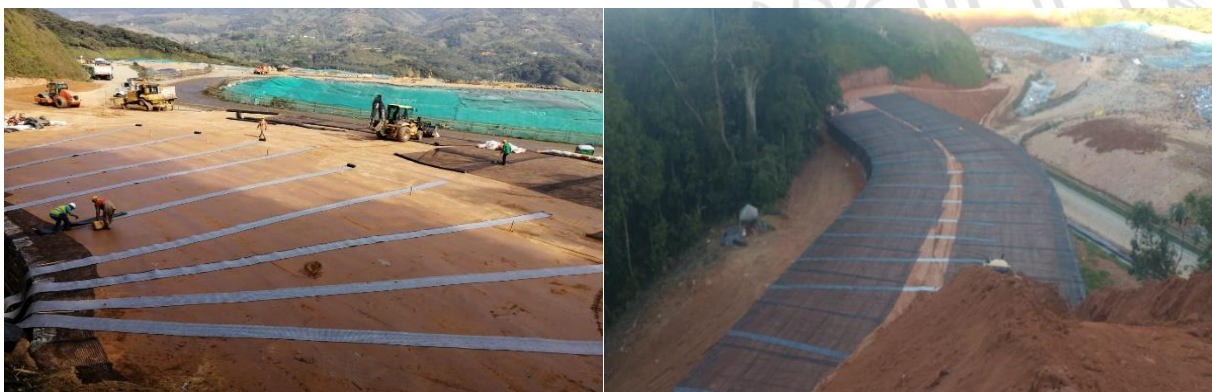
Imagen 7 Instalación de geodren
