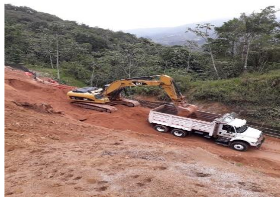
Imagen 8 Cargue de material en volqueta
