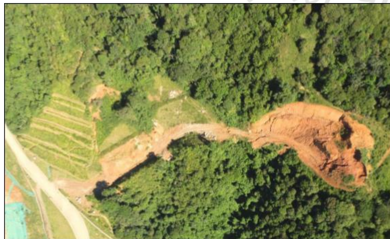
Figura 1 Tramo de vía construido con problemas de deslizamiento (Inteinsa, 2018)
