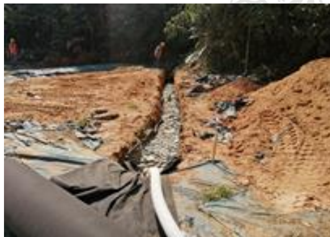
Imagen 3 Lleno con material granular filtrante
