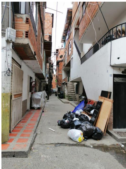
Imagen 3 Esquina de sendero peatonal considerado punto crítico
