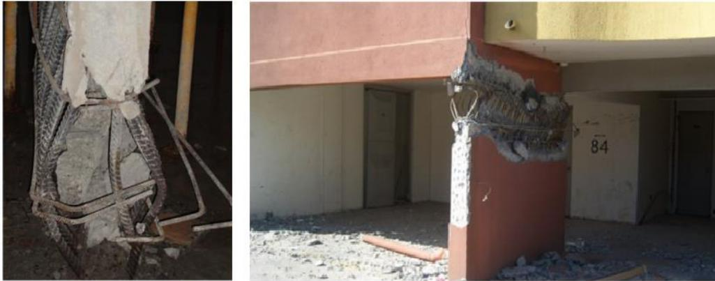
Figura 1.5. Falla flexo-compresiva de muros de CR durante el sismo de Chile de 2010, caracterizada por aplastamiento del concreto, pandeo del refuerzo vertical y apertura del refuerzo horizontal [31].
