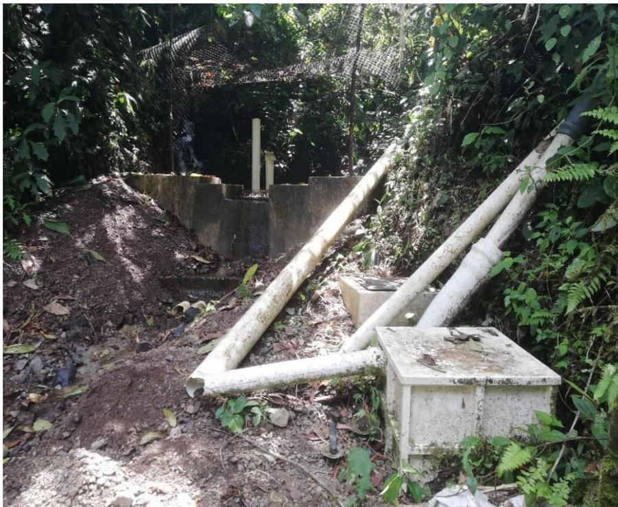
Figura 22. Caja de derivación ubicada después de la bocatoma.
