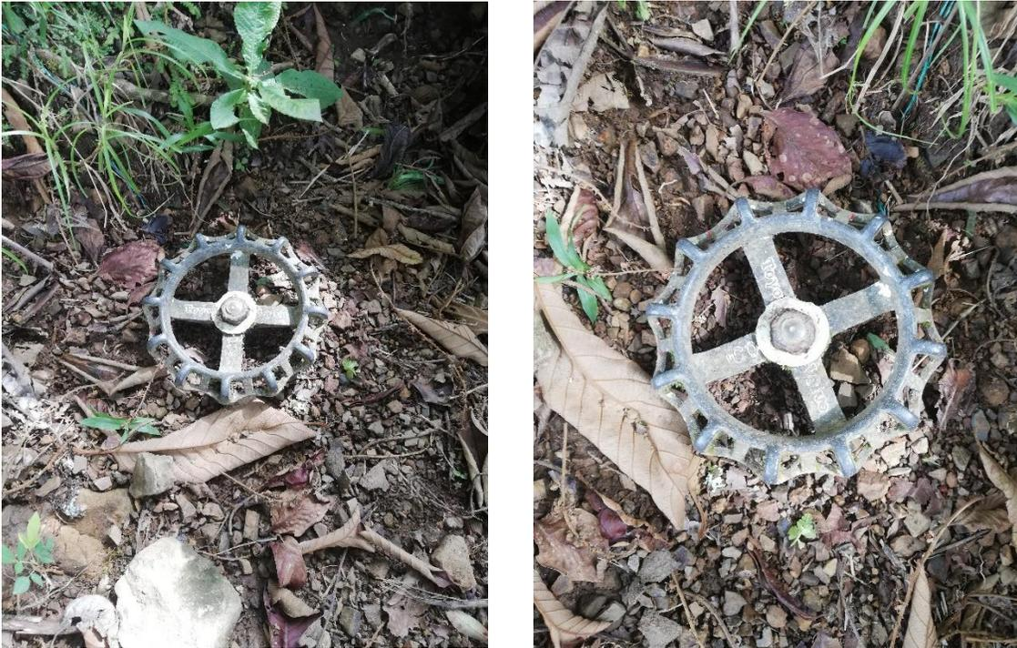
Figura 35. Válvulas de paso de la línea de conducción se encuentran en buen estado.
