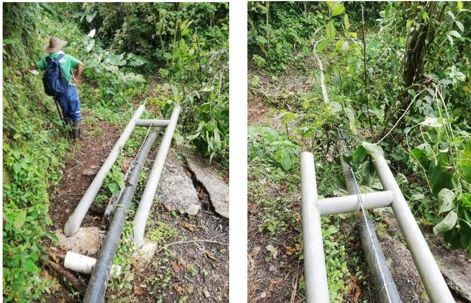
Figura 33. Daño en los estribos del paso elevado por deslizamiento.
