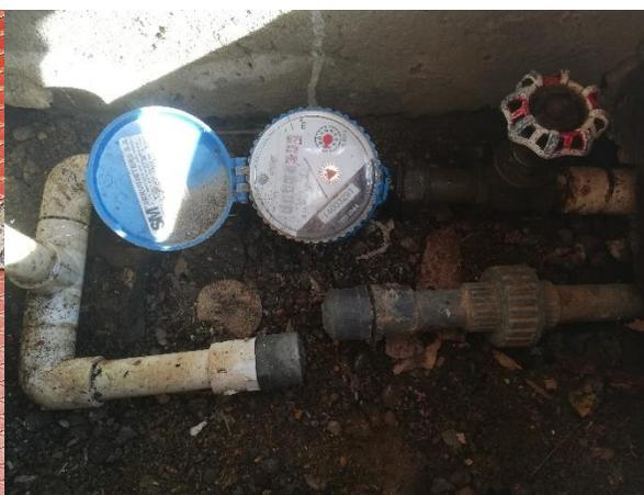
Figura 40. Contador en la conexión domestica a la red de distribución del nuevo acueducto y antiguo acueducto desconectado.
