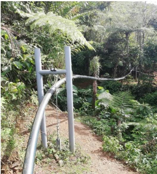
Figura 31. Estribos de soporte de la línea de conducción.
