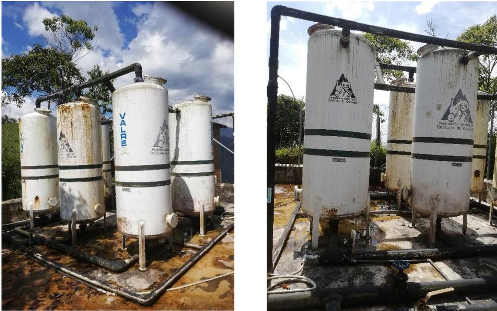
Figura 37. Sistema de filtración compuesto por seis (6) filtros.
