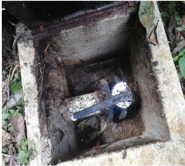
Figura 15. Válvula de paso de la línea de aducción.
