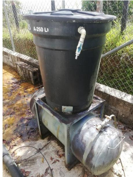
Figura 38. Sistema de tratamiento químico por cloración dosificado.
