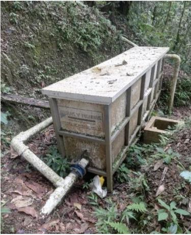
Figura 19. Tanque desarenador, punto de entrada, purga en el medio y salida al fondo.
