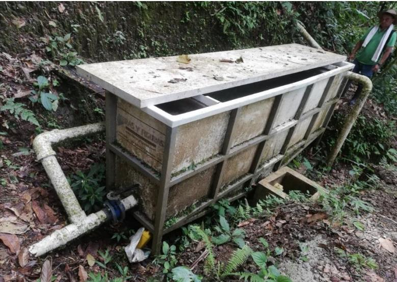
Figura 18. Tanque desarenador.
