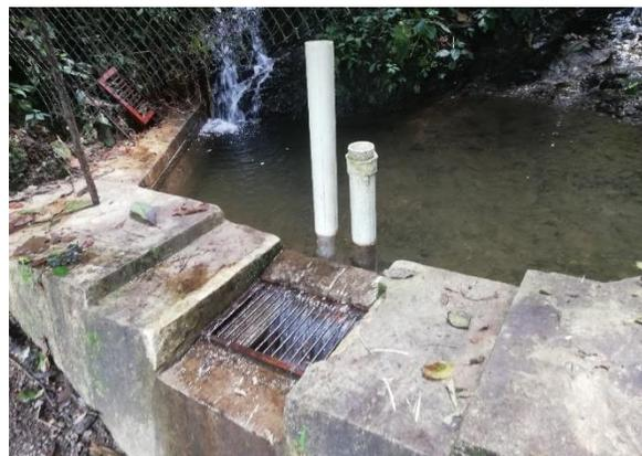
Figura 12. Bocatoma 2 observación del estado de la rejilla.
