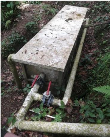
Figura 20. Tanque desarenador unión de las dos líneas de aducción.
