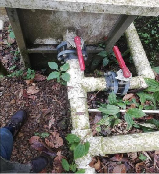
Figura 14. Línea de aducción válvulas de entrada al tanque desarenador.
