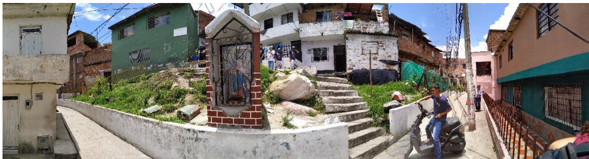
Ilustración 53 Se evidencia el uso de los andenes como zonas de circulación de motos. Foto panorámica tomada por la autora del sector los ranchos marzo de 2019
