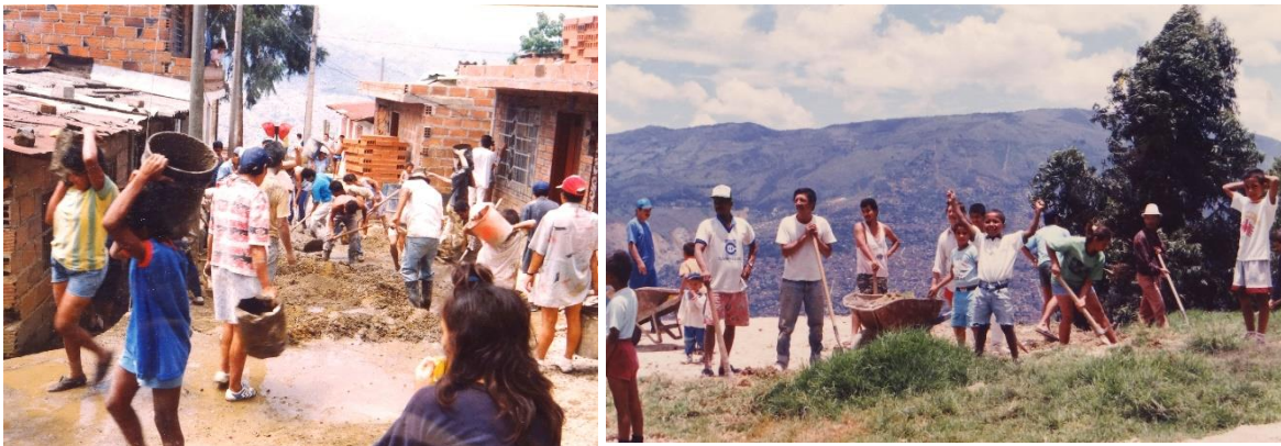
Ilustración 24 Construcción de la parte alta de la comuna 6. Archivo Fundación Social Medellín década de 1980.
