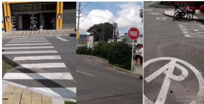
Ilustración 18. Señalización carrera 13 entre calles 19 y 21
