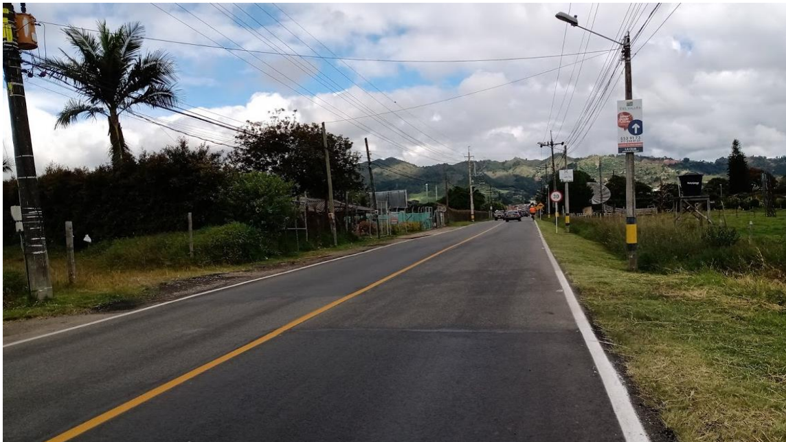
Ilustración 58. Calle 19 entre la glorieta de la vía a La Unión y la carrera 13
