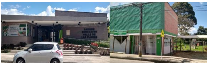
Ilustración 22. Equipamientos calle 21 entre carreras 13 y 17
