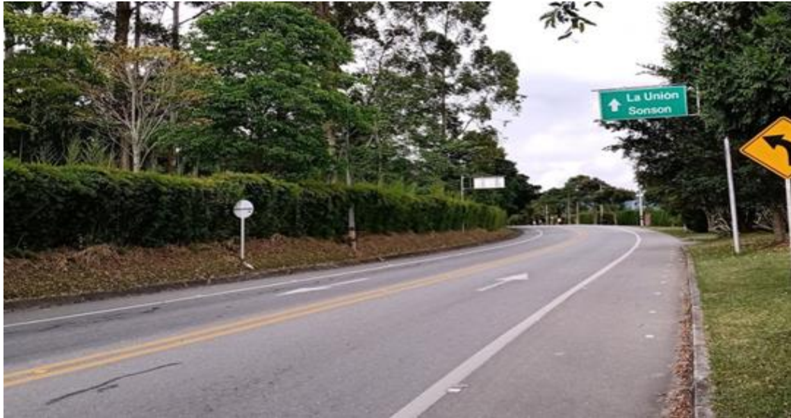
Ilustración 57. Tramo circunvalar sur entre glorieta vía a Rionegro y glorieta vía a La Unión
