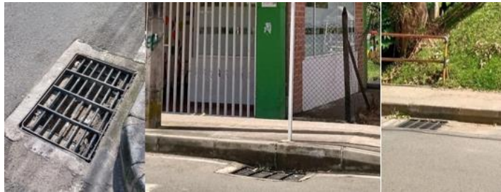
Ilustración 25. Sumideros calle 21 entre carreras 13 y 17
