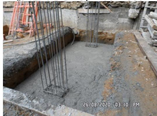
**Imagen 50** Vaciado de zapatas
