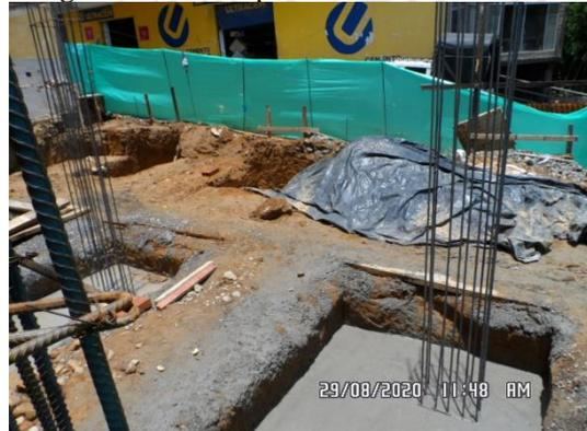
**Imagen 29** Zapatas vaciadas.
