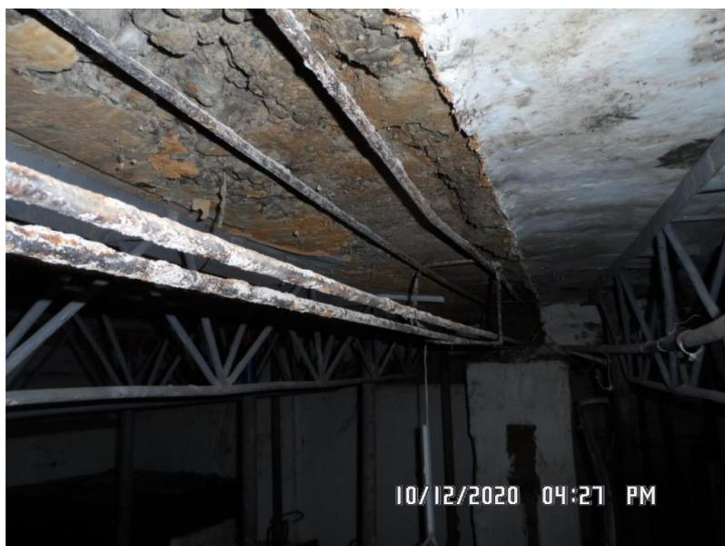
**Imagen 7** Viga sin estribos suficientes
