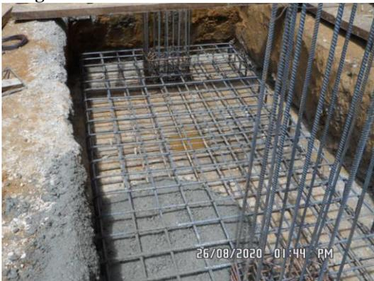
**Imagen 49** Armado de hierro zapatas
