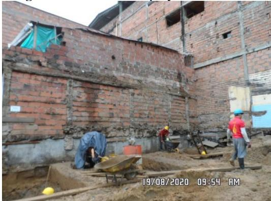
**Imagen 28** Excavación de cimentaciones
