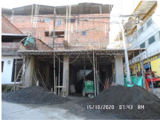
**Imagen 32** Losa segundo nivel.
