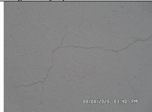
**Imagen 15** Ejemplo de mapeo de fisuras
