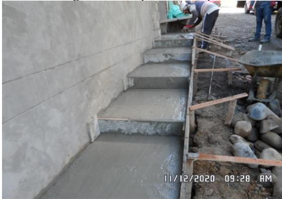
**Imagen 44** Vaciado de escalas.
