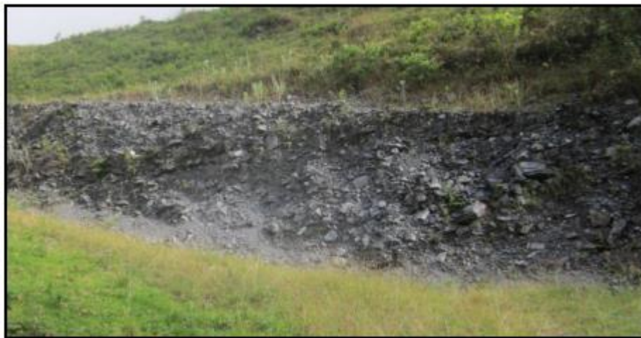
Figura 7: Talud del Depósito el Galpón con gran variación de tamaño de los fragmentos Fuente: Propia
