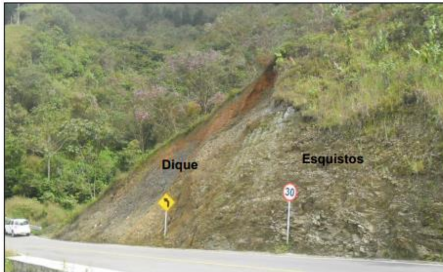
Figura 6: Afloramiento de esquistos y dique intrusivo en la vía industrial Tomado de: Consultoría Inteinsa 2013
