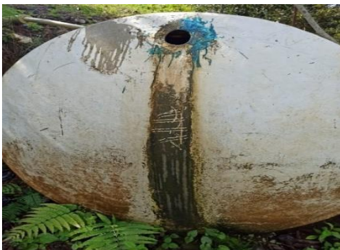
Figura 9. Tanque tratamiento de lixiviados Antes.
