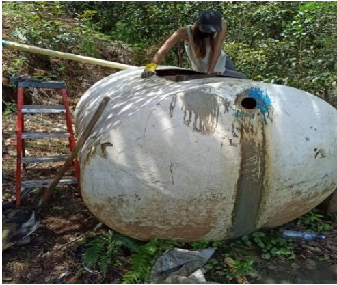
Figura 11. Mantenimiento al tanque.
