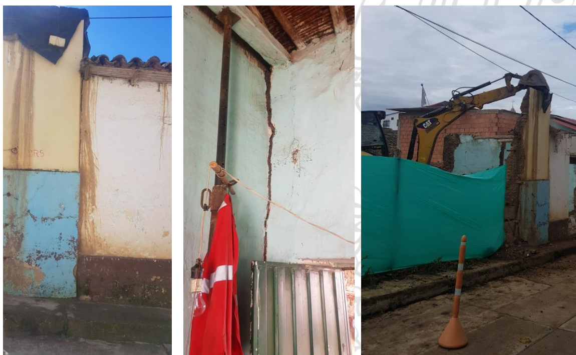
Figura 9 Demolición tapia predio colindante.
