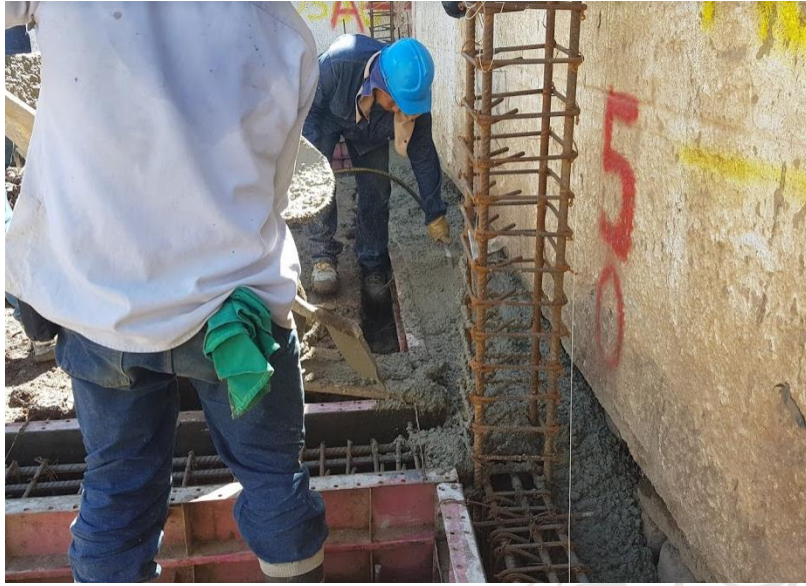
Concreto 3000 Psi Para Columnas
