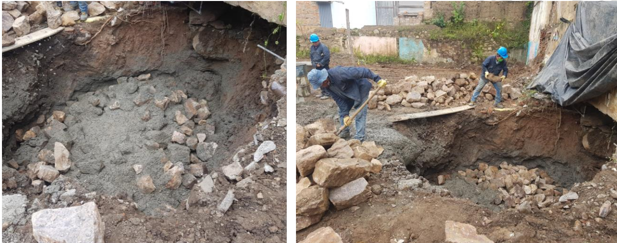
Figura 7 Concreto ciclópeo aplicado para mejoramiento del suelo.
