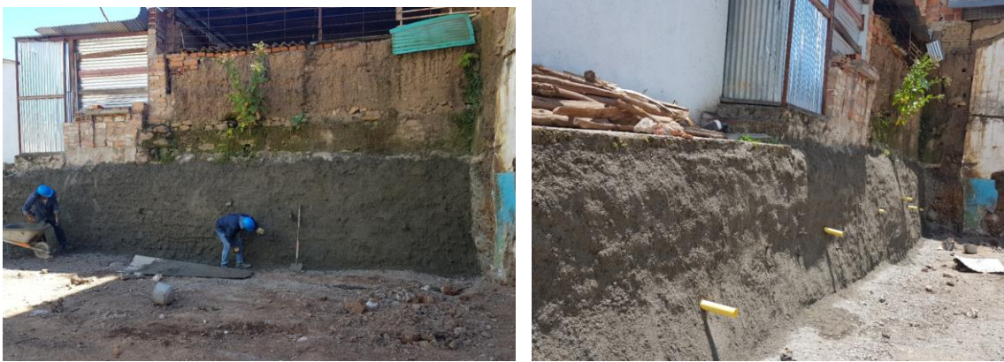
Figura 10 Actividades de mejoramiento de talud.
