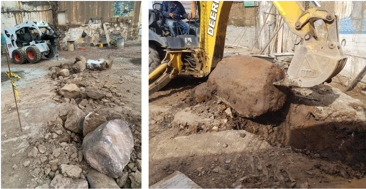
Figura 5 Rocas en excavaciones a menos de 1m de profundidad.
