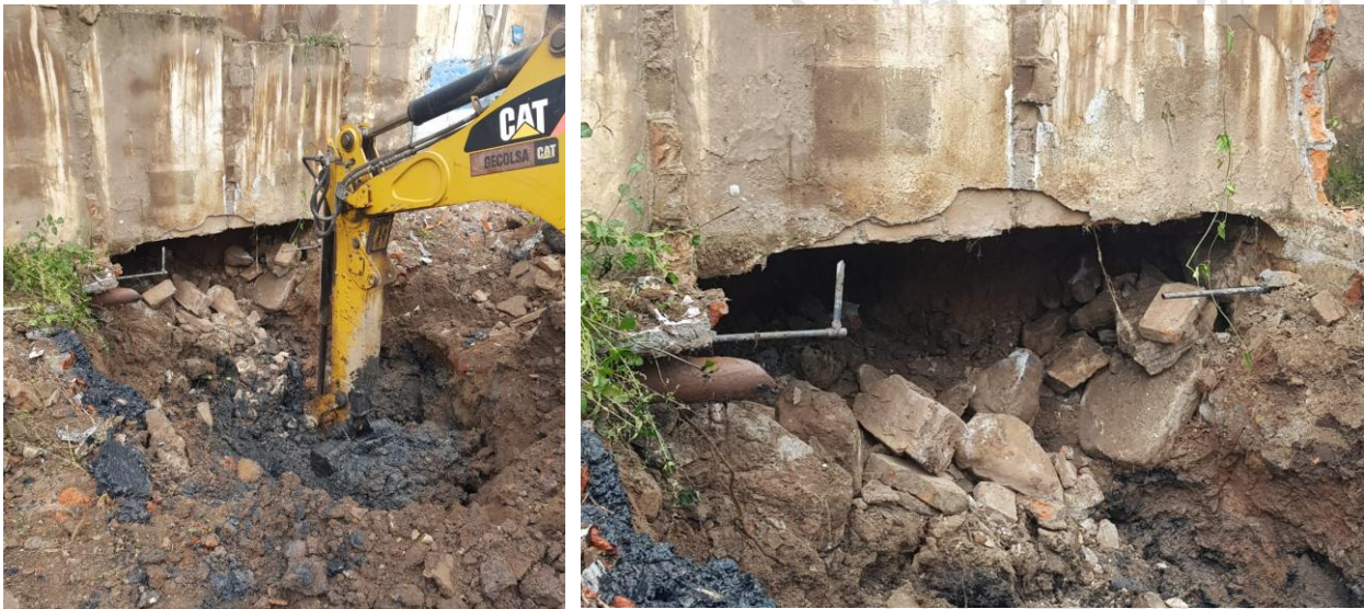
Figura 6 Pozo séptico encontrado durante la excavación.
