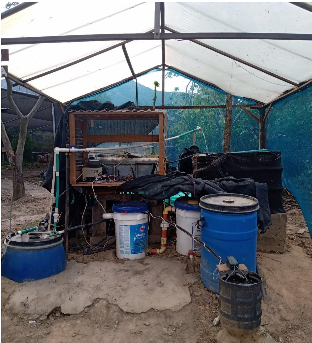
Figura 11 Construcción total del sistema acuapónico
