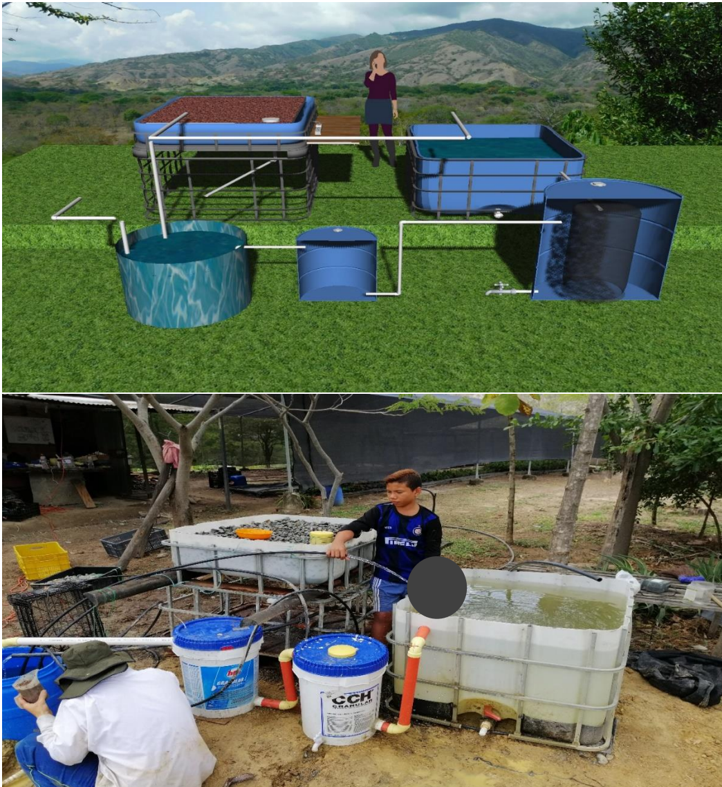
Figura 8 Primer diseño del sistema acuapónico y su construcción
