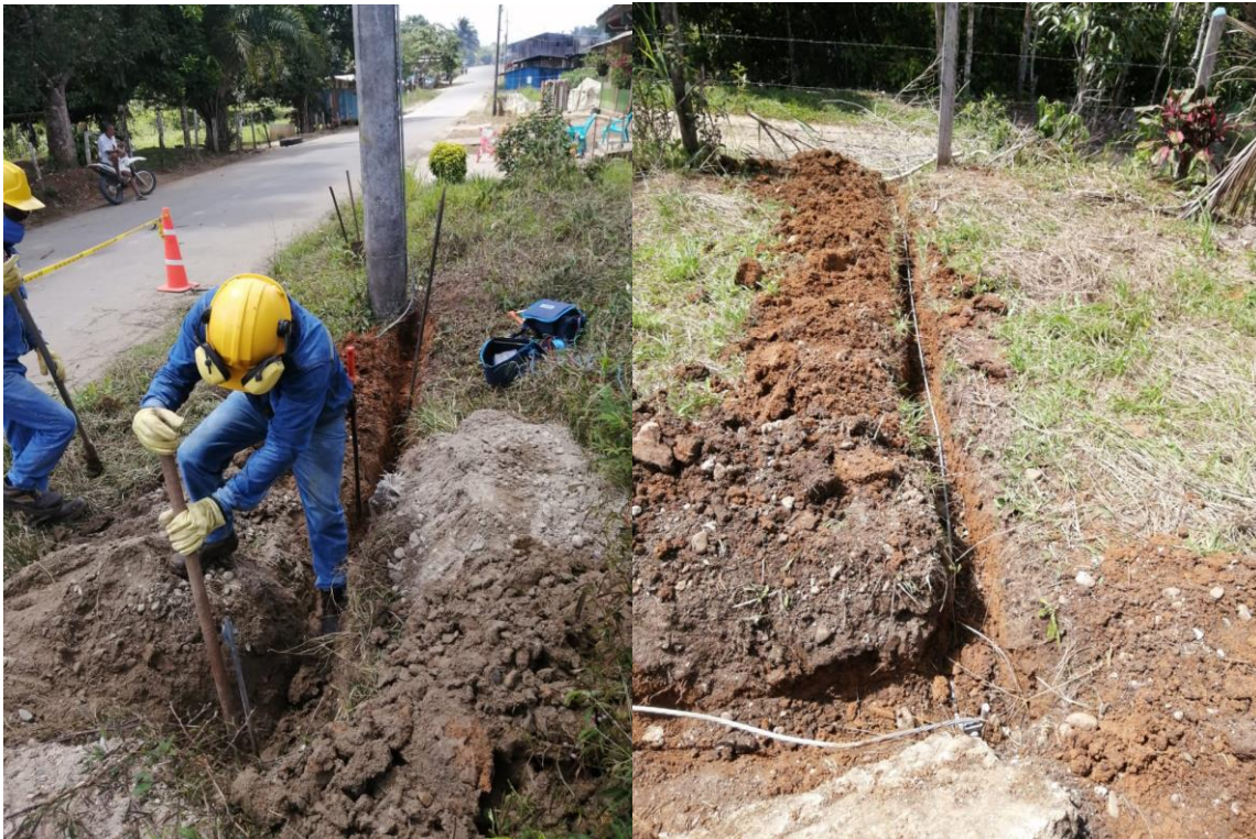
Imagen 1. Implementación del sistema de puesta a tierra.
