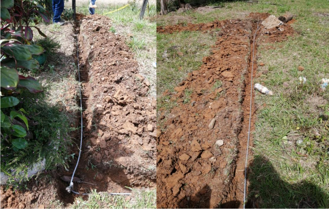
Imagen 2. Implementación del sistema de puesta a tierra.
