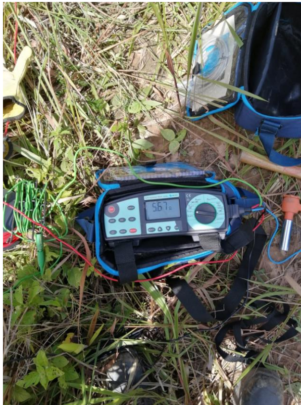
Imagen 3. Resistencia de puesta a tierra medida.
