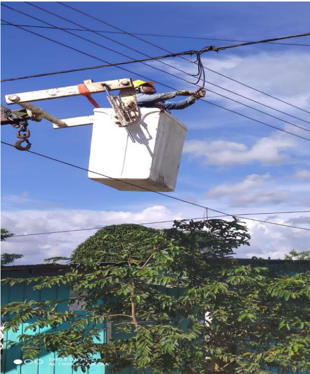
Imagen 5. Cambio de red abierta a trenzada.
