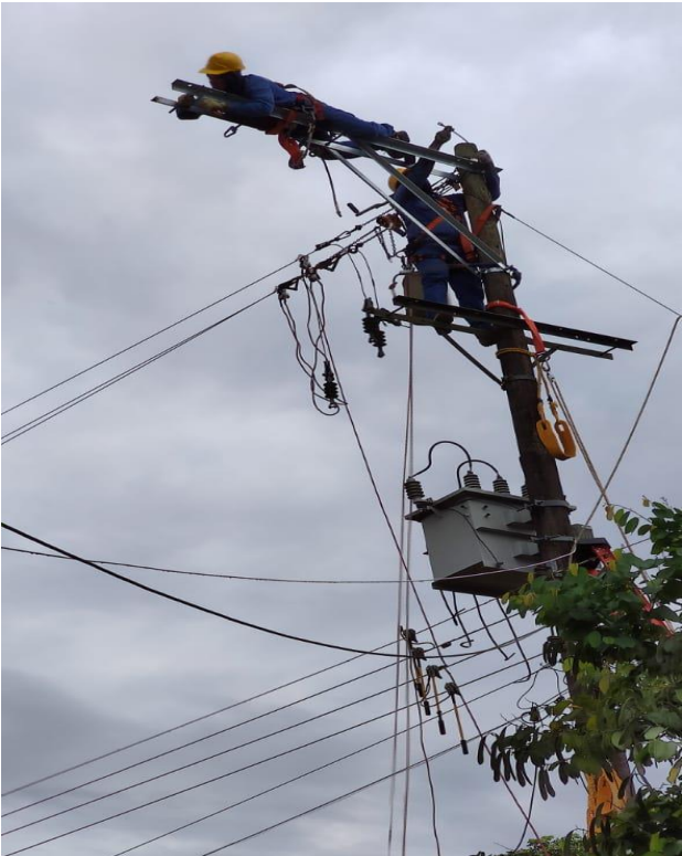
Imagen 7. Instalación red de media tension.
