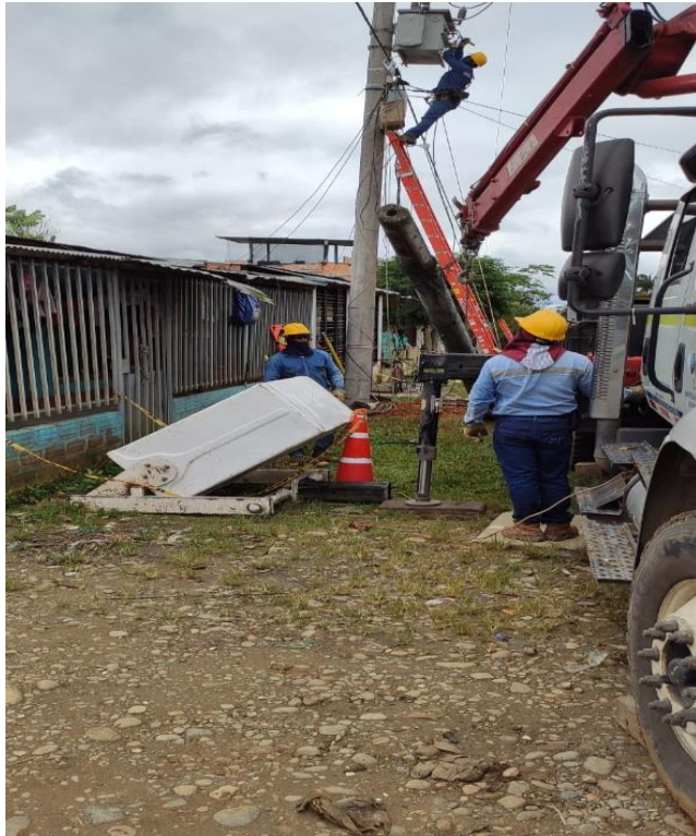
Imagen 4. Instalación caja de derivación.
