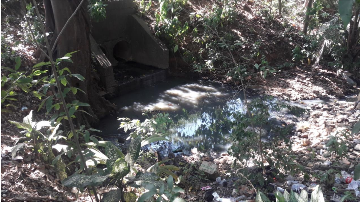
Imagen. 6. Evidencia de la problemática de contaminación el nacimiento de agua oro perdido
