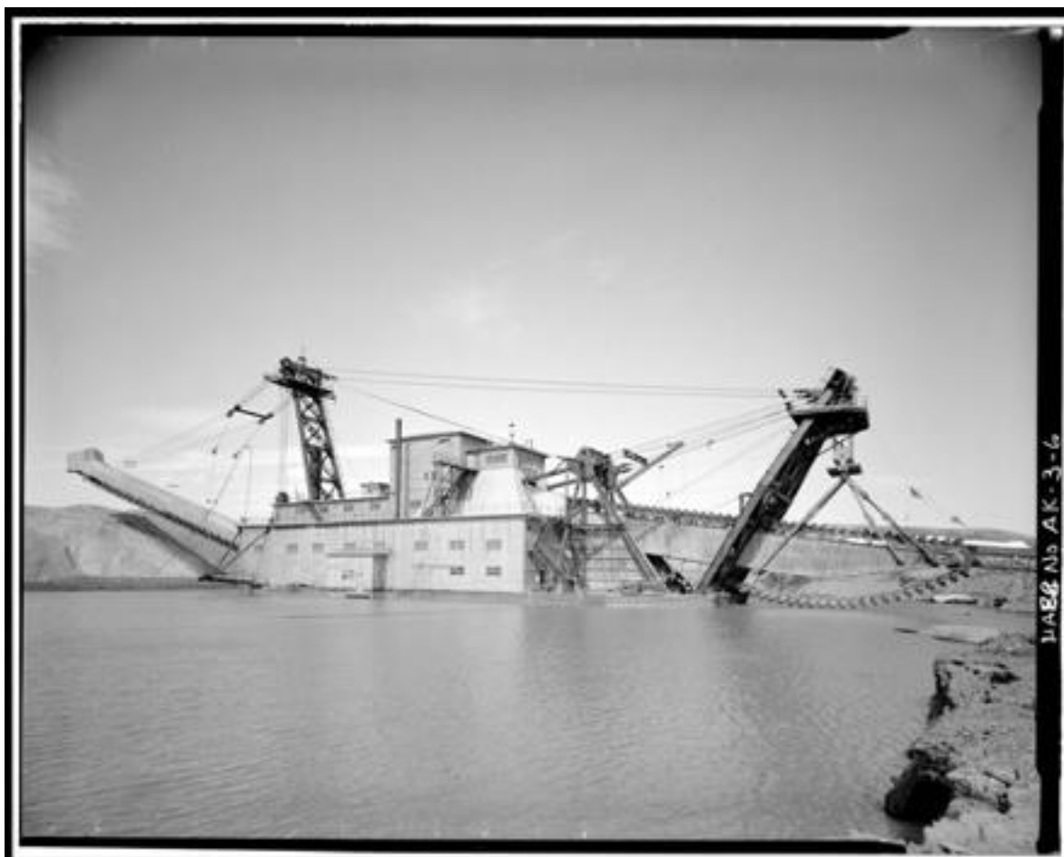
Figura 6. Draga tipo Bucket-elevator , # 5, utilizada por la compañía Hammon Consolidated Gold Fields en Alaska. Fabricada por la extinta empresa de diseño y construcción de dragadoras St. Clements. Fuente: Library of Congress (1941).
