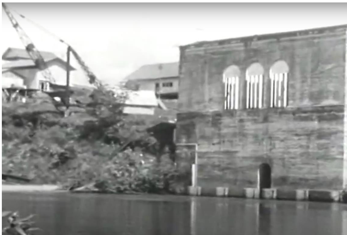
Figura 12. Fotografía de la hidroeléctrica La Vuelta, en el alto Andágueda, se puede observar la represa hidroeléctrica que contaba con un sistema de esclusas de elevadores que permitía el tránsito de las embarcaciones por el río La Vuelta. Fuente: A Journey to the Operations of the South American Gold Platinum Co , Kathleen Romoli (1937).
