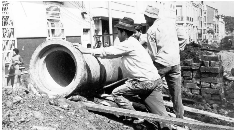
EPM 60 años – instalación de tubería Plan Piloto de Alcantarillado, en: Plan_piloto_construccion_de_alcantarillado_-_Calle_Ayacucho.jpg
