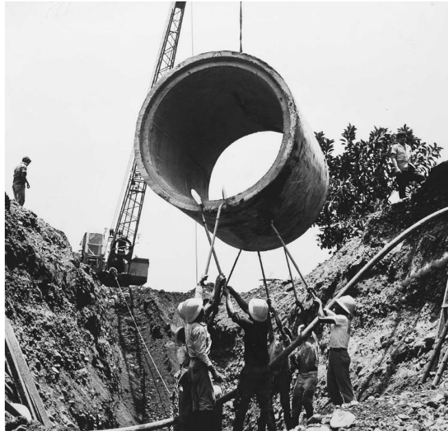
EPM 60 años – instalación de tubería Plan Piloto de Alcantarillado en: Plan_piloto_alcantarillado_agno_1969.jpg
