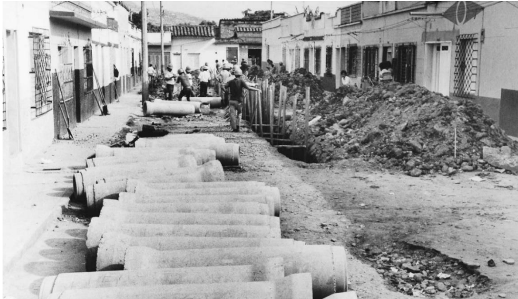
EPM 60 años – instalación de tubería Plan Piloto de Alcantarillado, en: Trabajos_de_alcantarillado_en_el_municipio_de_Bello_-_Carrera_45_x_calles_51_-_52.
