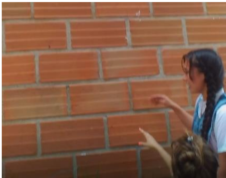
Figura VII: Medición de la altura de una estructura por estudiantes de la I.E.R. Nuestra Señora del Carmen. Tomado de Ramírez, Restrepo-Puerta y Cardona (2019, en prensa)
