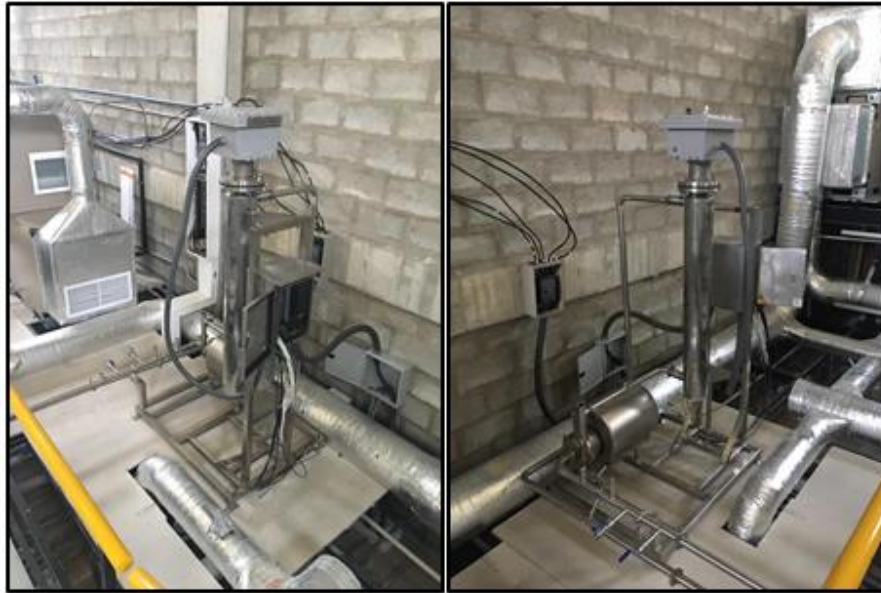
Figura 18. Chiller de calentamiento [Realización propia].
