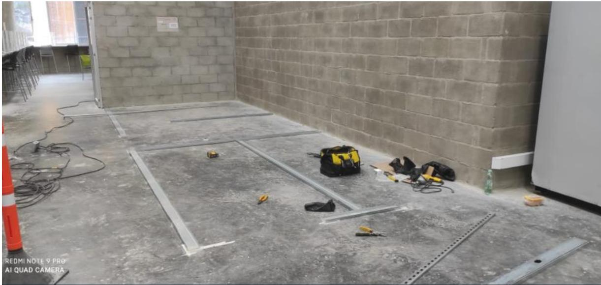
**Figura 6.** Marcación en sitio para garantizar nivel en los muros y asegurar canales metálicos a losa de concreto.
