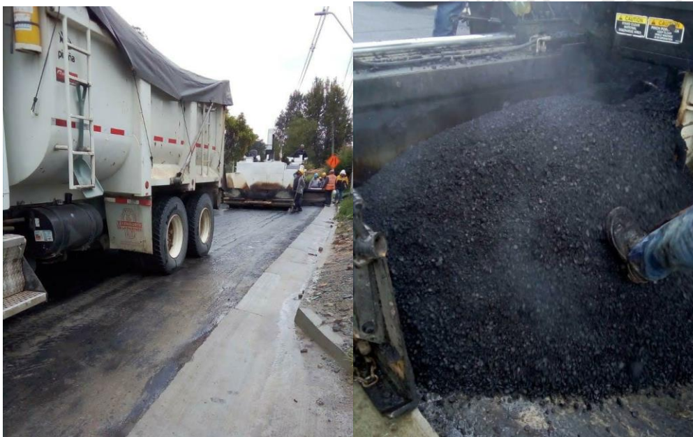
Imagen 5. Toma de muestra de mezcla asfáltica en caliente. Fuente: Cesar García laboratorista de Evaltec S.A.
