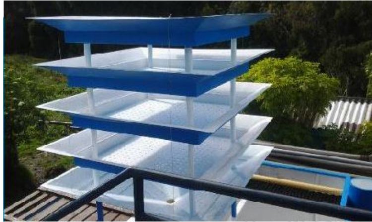
Figura 1. Torre de aireación por bandejas.
