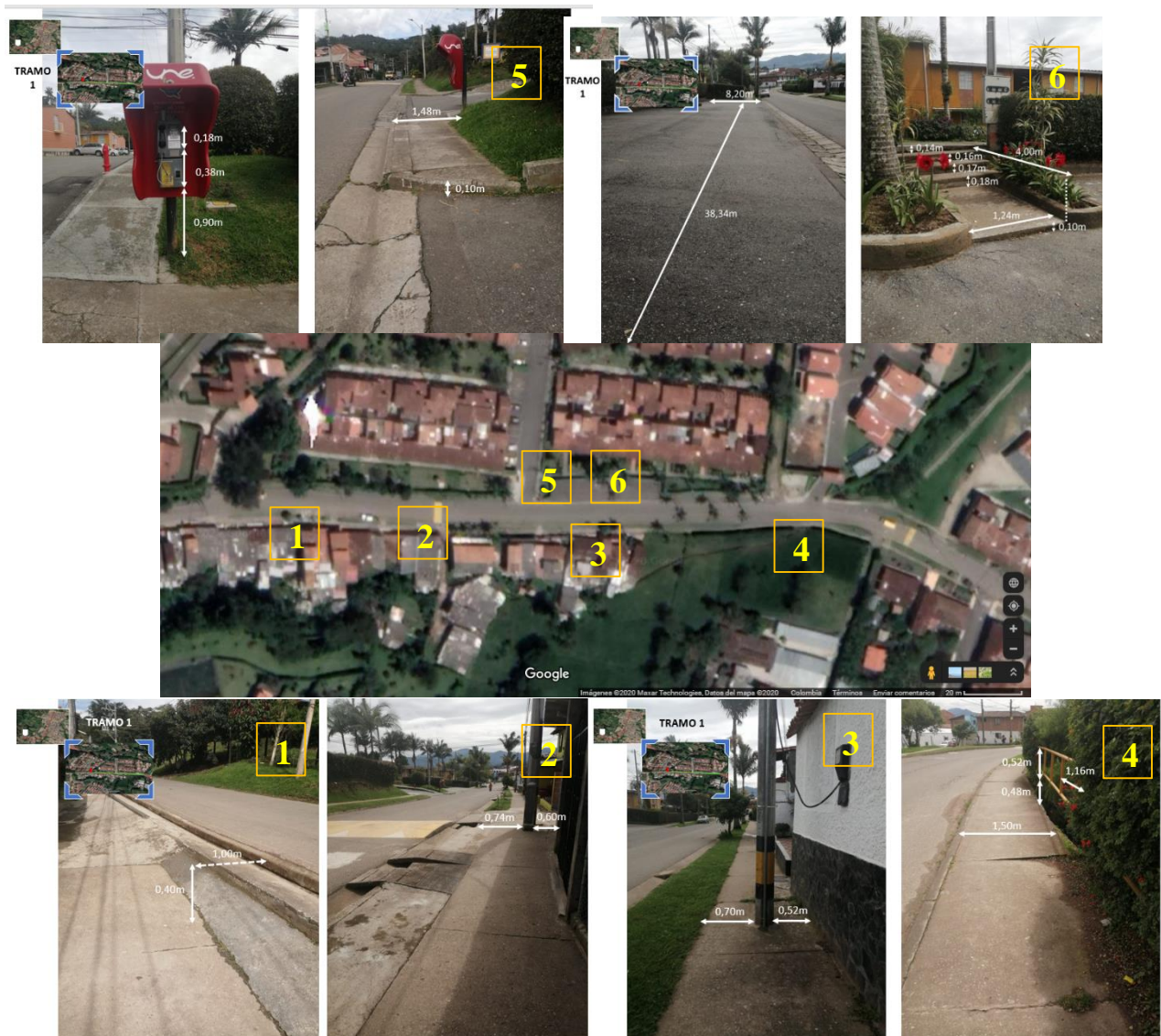
Estado Actual del Tramo 1
