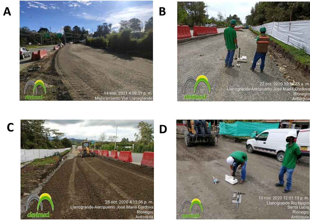
Fig. 3 Construcción de la estructura para la vía. a. Instalación de base granular en primera capa, grosor por diseño determinado en 30 cm, compactada con rodillo vibrador y con un GDI > 98\% . b. Toma de densidades en primera capa de base granular, con datos de caracterización proporcionados por Suelos y Pavimentos del material usado, caracterización que se hace mensual y se recibe de cada proveedor de base granular. c. Instalación de segunda capa de base granular de 30 cm de grosor compactado con rodillo vibrador. d. Toma de densidades en segunda capa, solución de fallos y céreo para pavimentación
