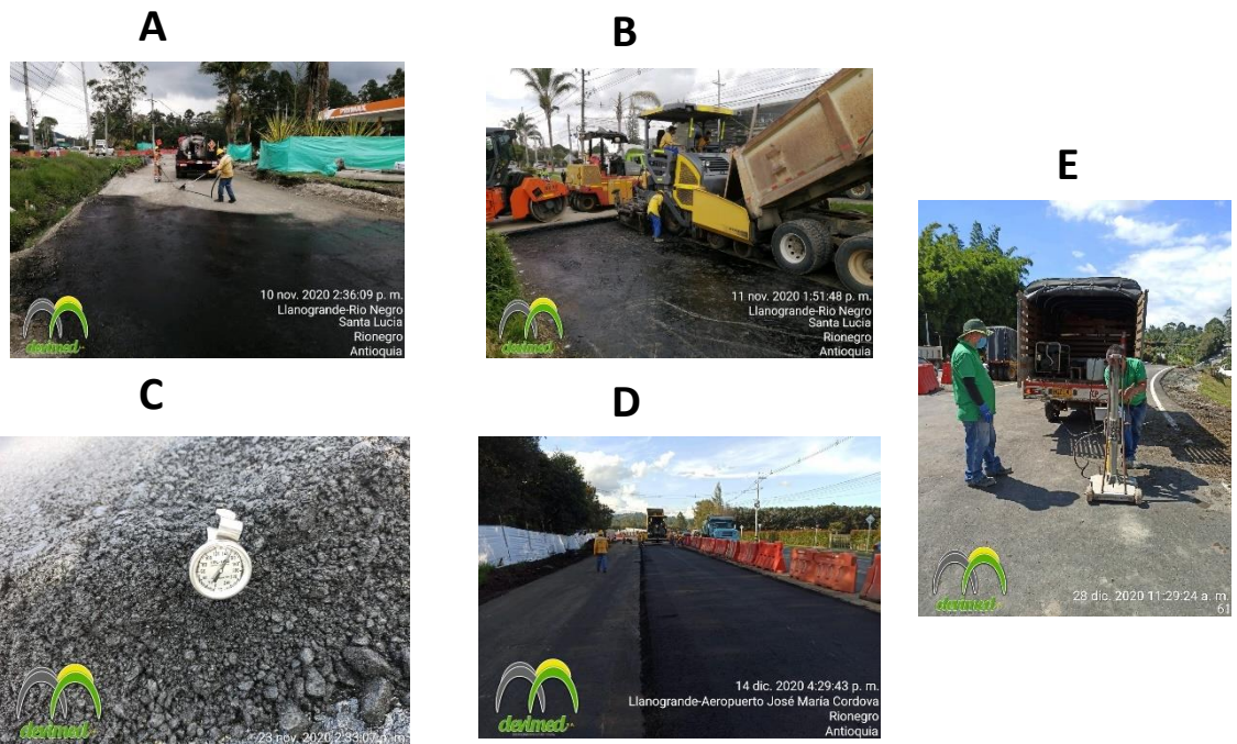
Fig. 4 Proceso de pavimentación. a Imprimación con emulsión asfáltica. b Instalación de primera capa de pavimento con mezcla MDC 25 y grosor de capa 80mm y toma de muestra para granulometría. c Toma de temperatura de mezcla al momento de la pavimentación, la mezcla debe ser instalada a una temperatura no inferior a 140° C para primera capa de pavimento y capa de rodadura. d Pavimentación de segunda capa con diseño de mezcla MDC 19, extracción de muestreo para granulometría y contenido de asfalto, grosor 80mm. e Extracción de núcleos de pavimento para verificación de espesores y compactación para cada capa MDC 25 y MDC 19 en los tramos pavimentados en el proyecto, se realizan 8 días después de realizar la pavimentación con tránsito libre.
