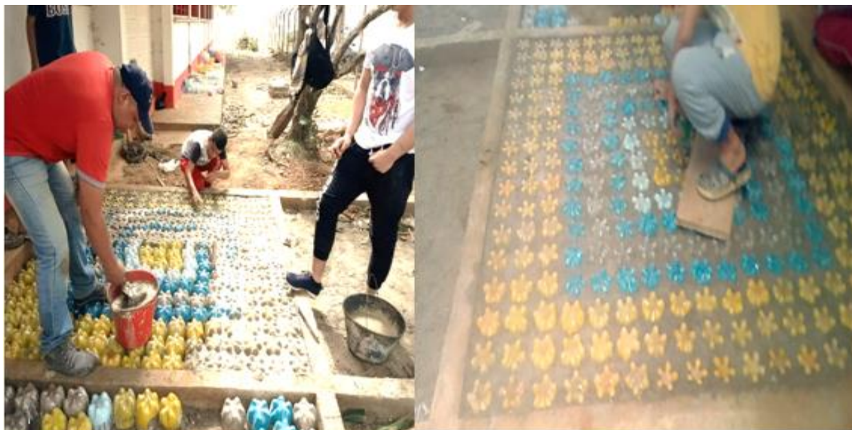
Figura 24: Fotografía de la placa huella, producto terminado (mayo 2019).
