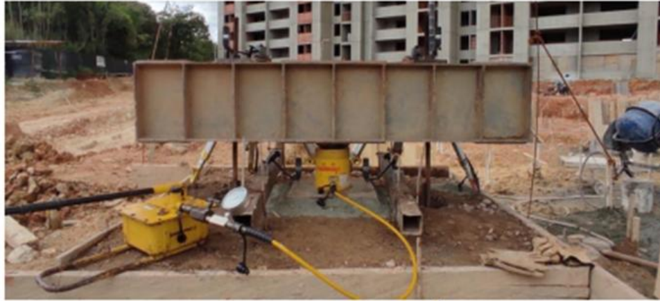
MONTAJE ESPERADO PARA PRUEBA DE CARGA A COMPRESIÓN DE 2 REACCIONES.
