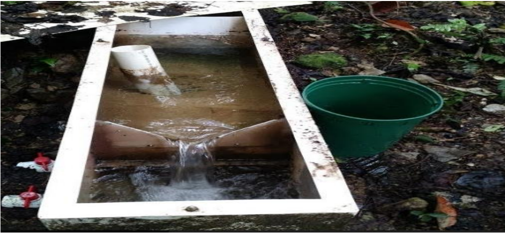
Figura 4. Cámara de control de caudal o Cárcamo.
