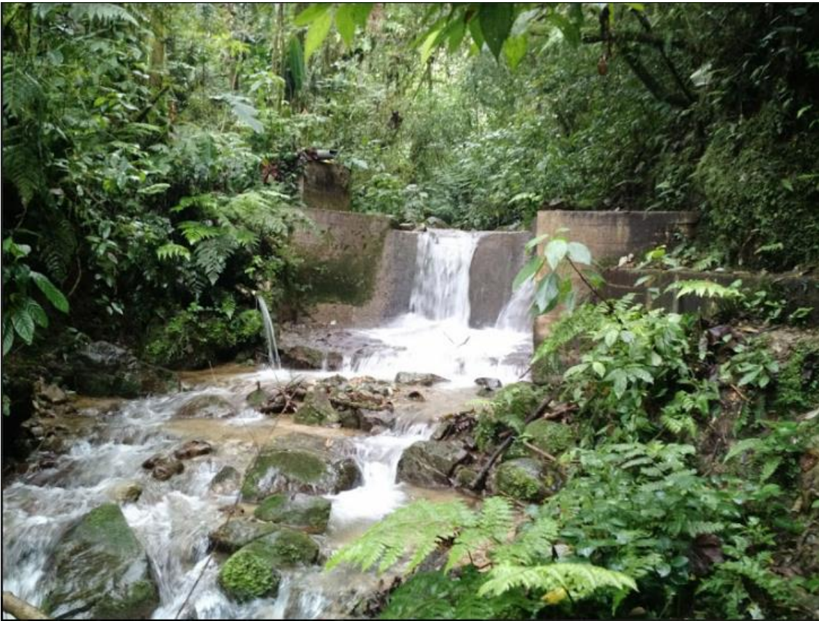
Figura 2. Bocatoma y el caudal la quebrada La Clara
