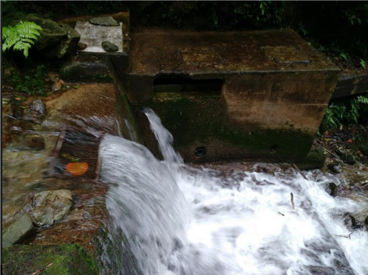
Figura 3. Rejilla de la bocatoma.
