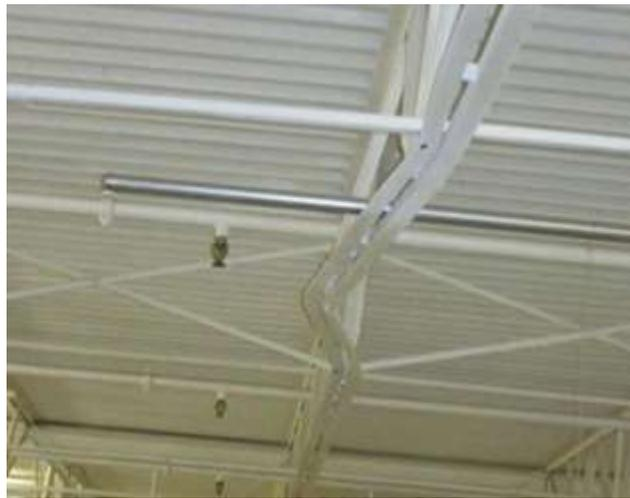
*Figura 4. Falla por pandeo en la cuerda inferior a causa de efecto de succión. Viento Ohio, 2008. Tomado de Steel Joist Institute*
