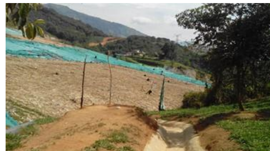
Cunetas para el desvío de aguas lluvias. Fuente: archivo del autor
