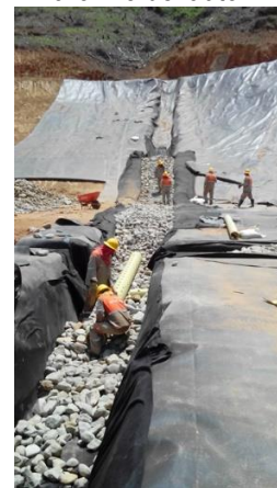
Cunetas para el desvío de aguas lluvias. Fuente: archivo del autor
