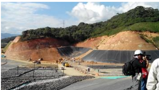
Impermeabilización del suelo. Fuente: archivo del autor
