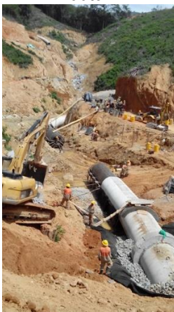
Impermeabilización del suelo. Fuente: archivo del autor
