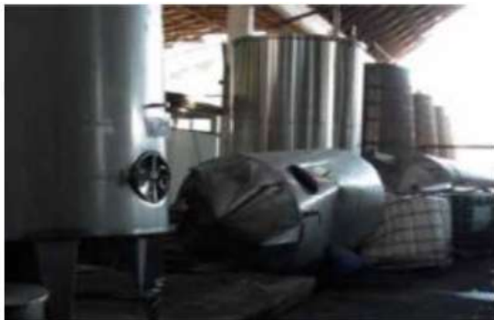
Figura 1-1 Daños en depósitos de vino en el sismo de Chile 2010
