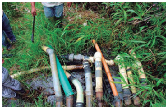
Bocatoma de los acueductos comunitarios pegada al rebose del Tanque Los Toldos
