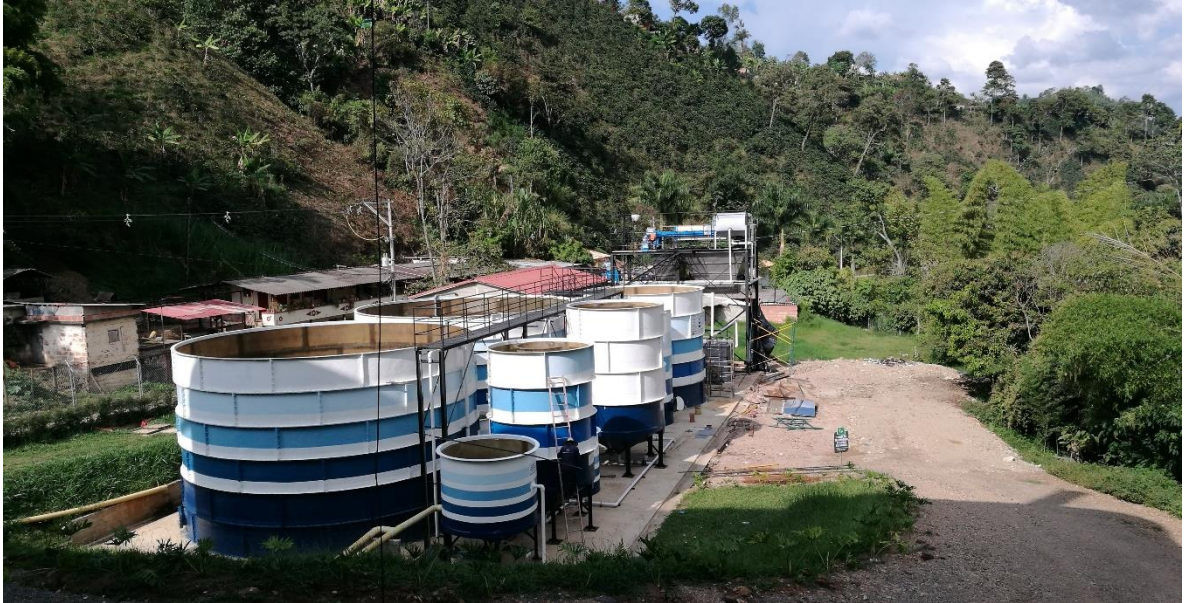
Figura 12. Planta de Tratamiento de aguas residuales.
