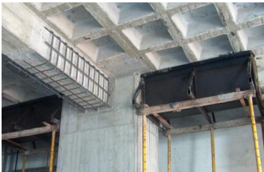
Ilustración 4. Reforzamiento de Viga con Concreto.
