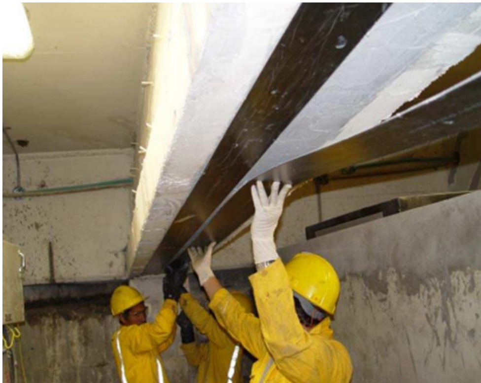
Ilustración 9. Instalación de Fibras de Carbono (FRP) en Viga.
