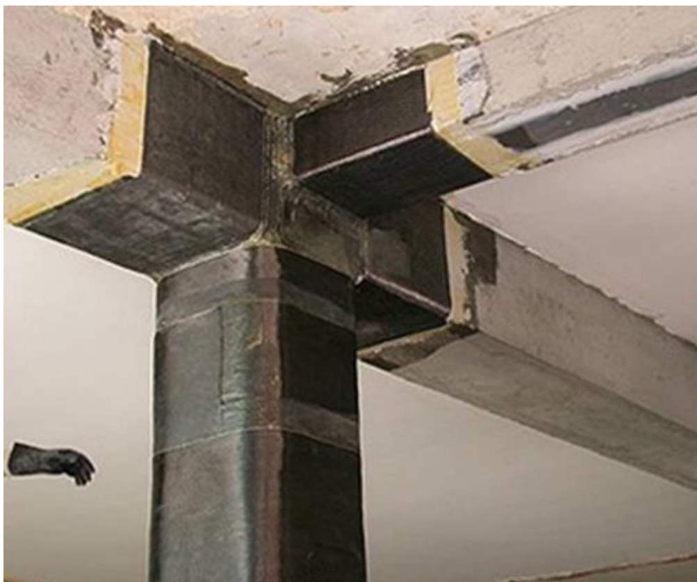
Ilustración 8. Nudo Reforzado con Fibras de Carbono (FRP).
