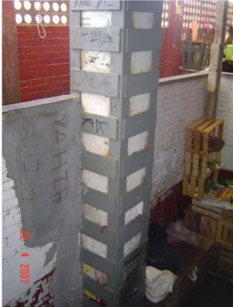
Ilustración 7. Encamisado de Columnas con Platinas de Acero.
