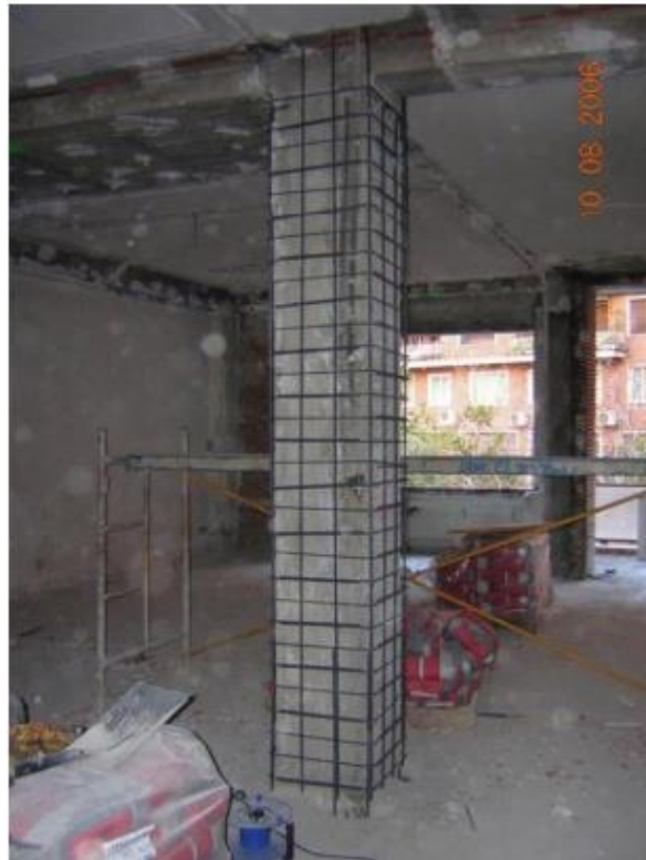
Ilustración 3. Reforzamiento de Columna en Concreto.
