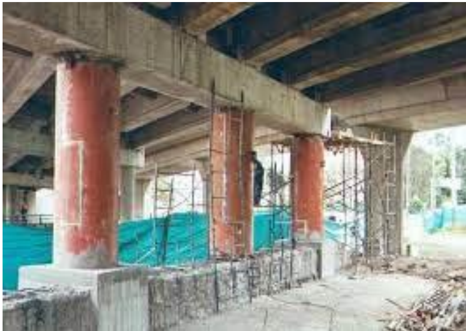
Ilustración 6. Encamisado de Columnas con Láminas de Acero
