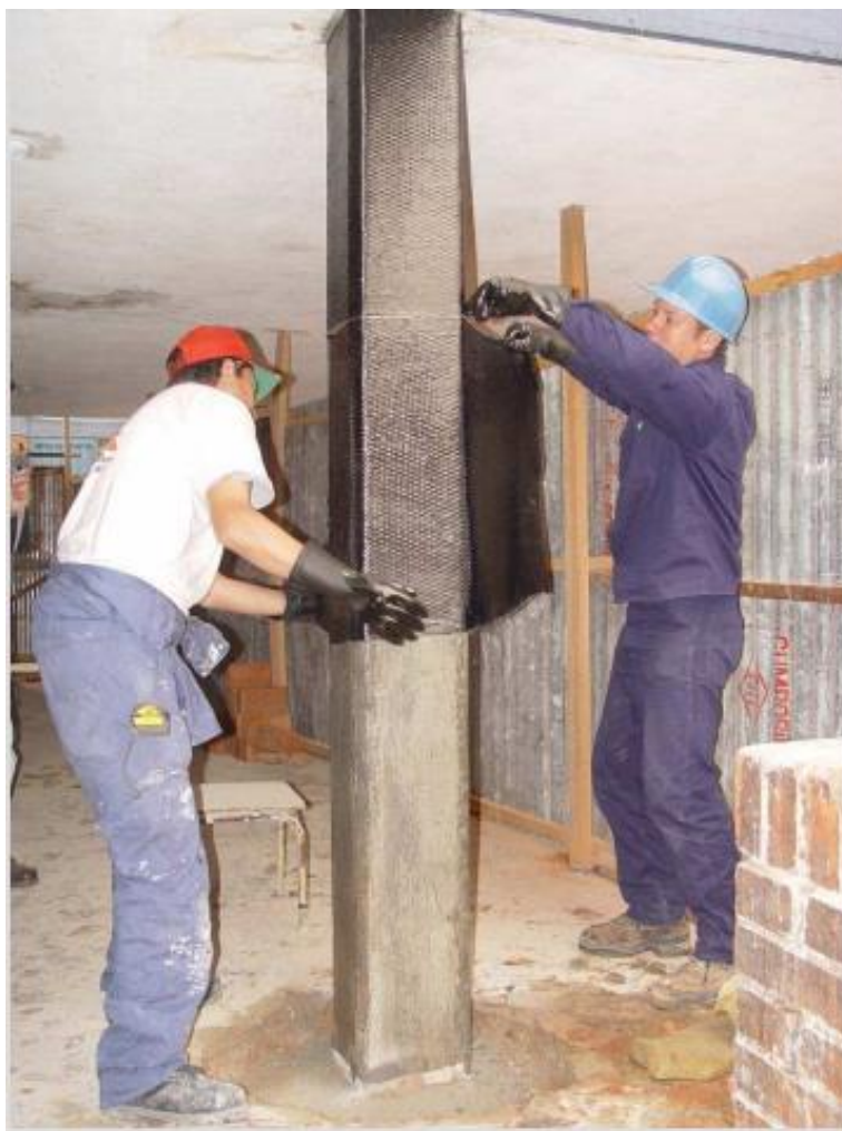
Ilustración 10. Instalación de fibras de carbono (FRP) en columna.
