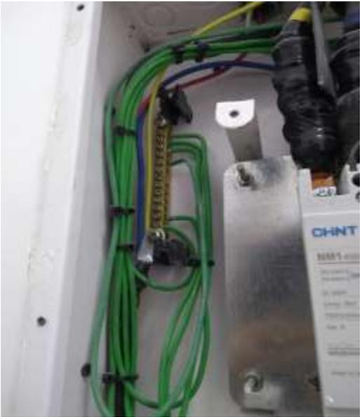
Figura 18. Cambio de conductores con aislamiento THHN/THWN por LSHF en el conductor de tierra.
