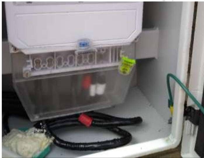
Figura 48. Sello plástico en medidor, constancia de legalización del servicio de energía.
