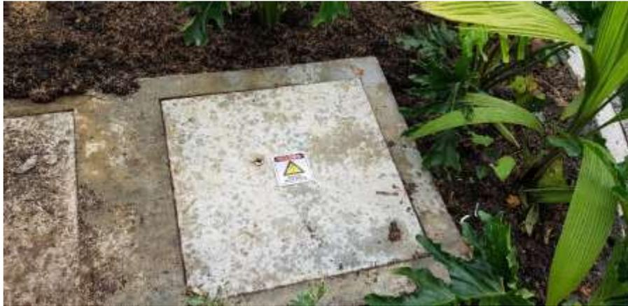
Figura 45. Marcación de riesgo eléctrico en caja subterránea.
