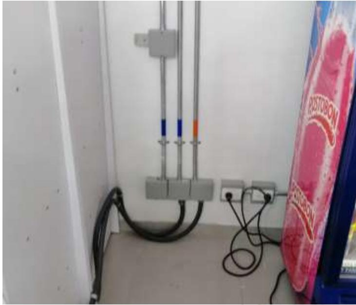
Figura 22. Marcación de tubería EMT con franja naranja de 10 cm.
