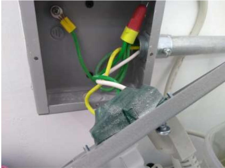
Figura 20. Equipotencialización con el conductor de puesta a tierra las cajas metálicas.
