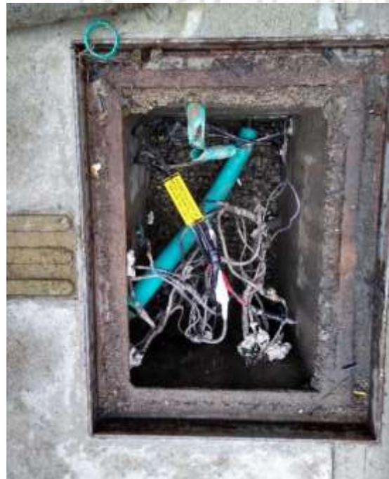
Figura 13. Acrílico de identificación para acometida y sellado de ducto con espuma expansiva.
