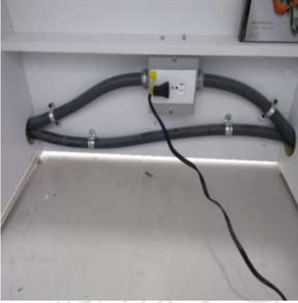
Figura 19. Adecuada fijación de la coraza flexible sobre el mueble existente en puesto de trabajo.
