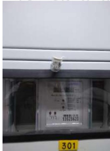
Figura 4. Sello plástico de identificación en puerta de medidores de energía.
