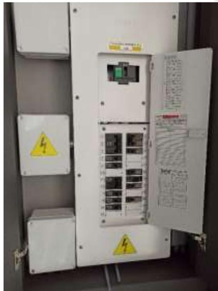
Figura 33. Protección principal adecuada para la instalación y marcación de tablero.
