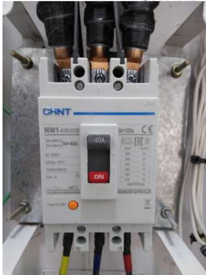
Figura 21. Protección adecuada para cumplir con la coordinación de protecciones.
