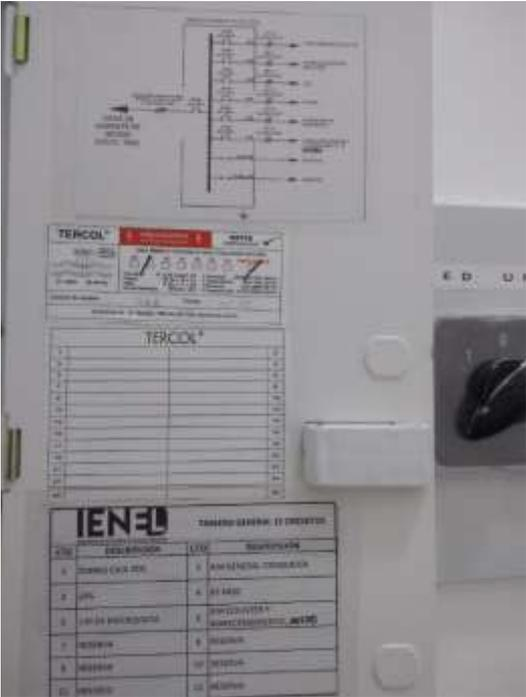
Figura 17. Diagrama unifilar y directorio de circuitos actualizado.
