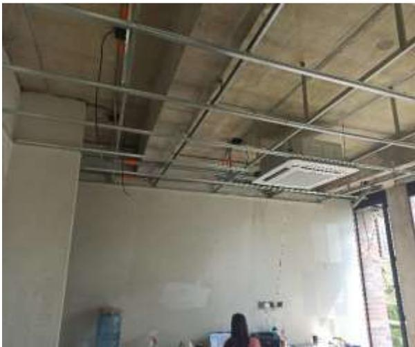
Figura 29. Tubería PVC SCH 40 en cielo con marcación naranja
