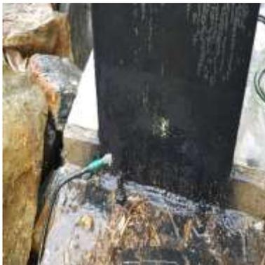
Figura 42. Equipotencialización de la estructura metálica con el conductor de puesta a tierra.
