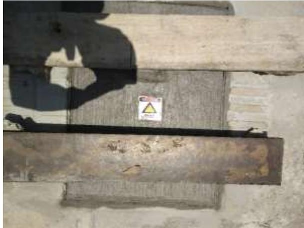
Figura 14. Placa de identificación de riesgo eléctrico en caja de distribución.
