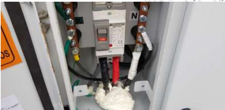
Figura 44. Puente equipotencial en gabinete y espuma expansiva en ducto de acometida.
