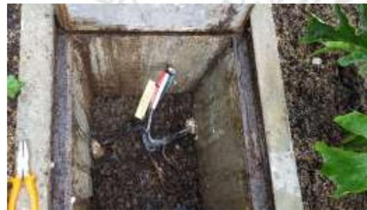
Figura 43. Identificación de circuitos en caja de distribución subterránea y sellado de ductos con espuma expansiva.
