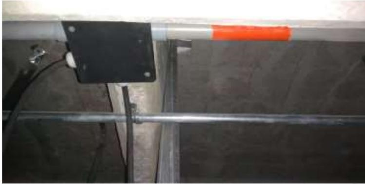
Figura 41. Cajas con tapas sobre el cielo y marcación naranja de tubería.
