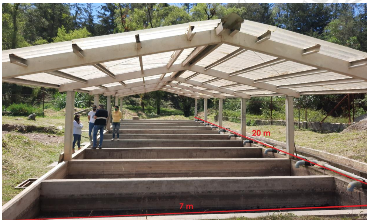
Figura 16. Dimensiones de lechos de secado construido PTAR San Vicente Fotografía tomada por Jessica Vargas
