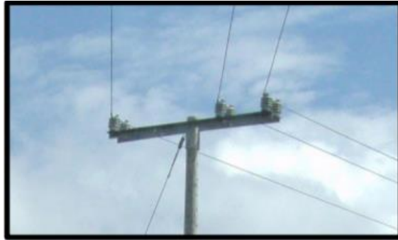
Figura 9. Armado en ángulo [3].
