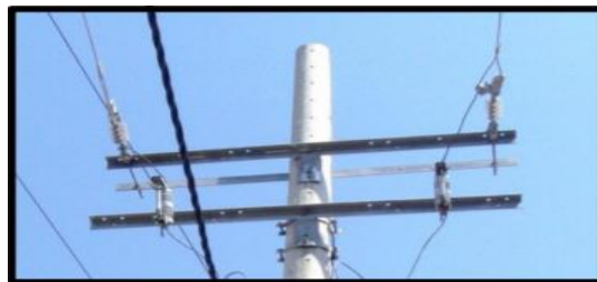
Figura 11. Armado fin de línea [3].
