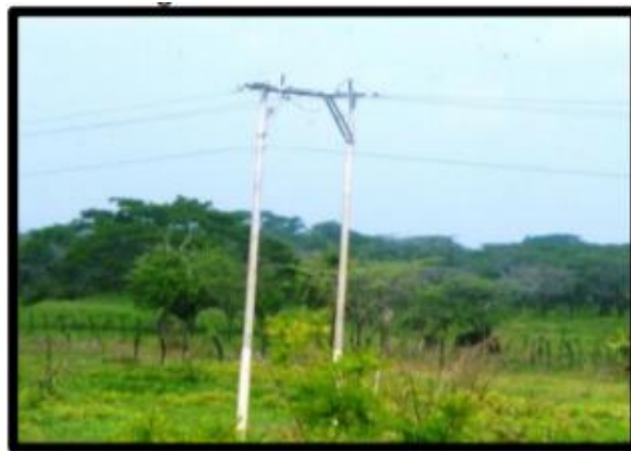
Figura 13. Estructura en H [3].
