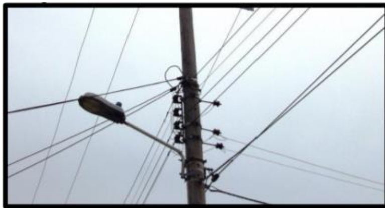
Figura 1. Red abierta de distribución secundaria [3].
