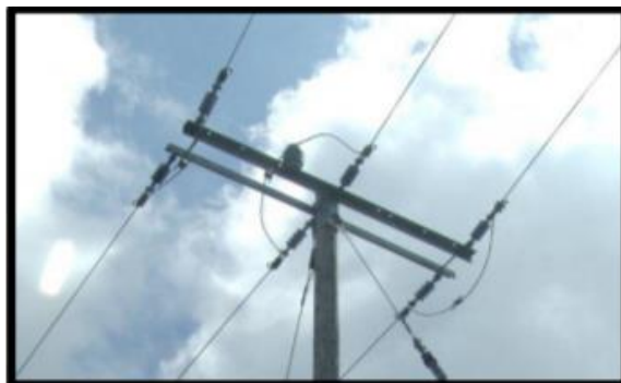
Figura 10. Armado en anclaje [3].
