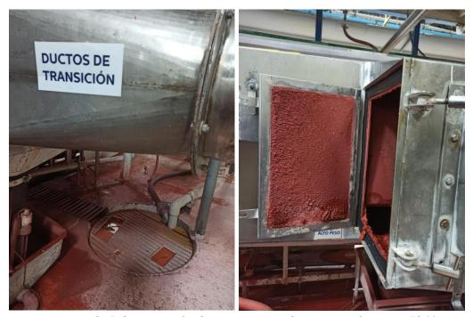
Imagen 6. Cabina esmaltadora contaminada con esmalte NEMC941
