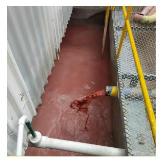
Imagen 4. Tanque Homogeneizador contaminado por esmaltes.
