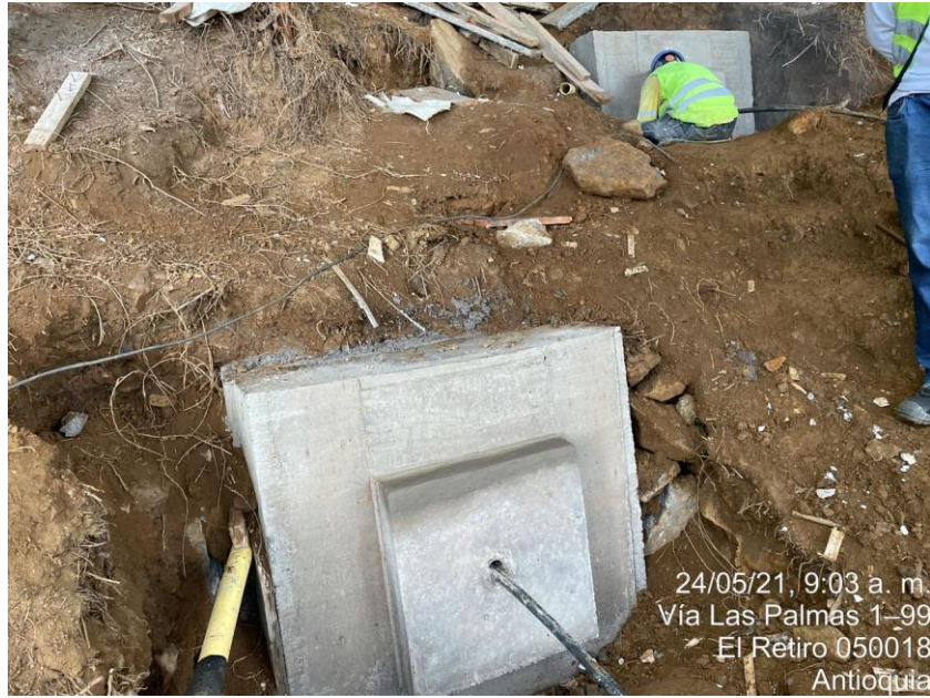
Ilustración 13. Anclajes realizados con BERETTA T-19 en el viaducto 13.
