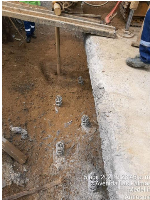
Ilustración 10. Micropilotes realizados con BERETTA T46-S2 en el viaducto 13.
