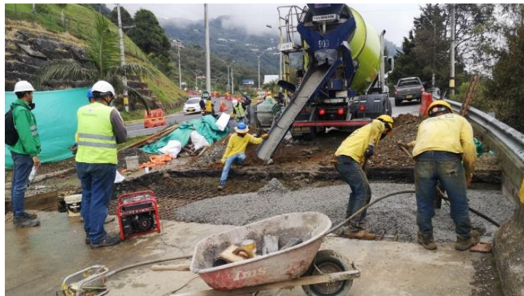
Ilustración 22. Fundición de losa de aproximación con concreto acelerado del viaducto 13.
