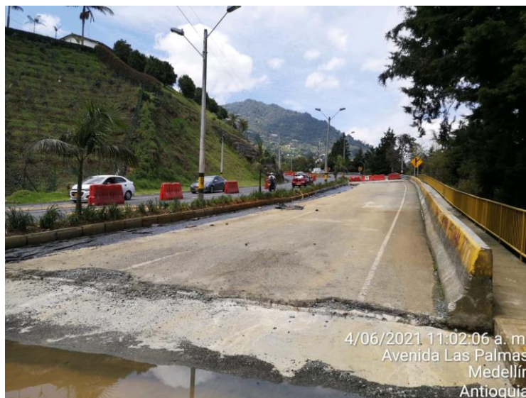
Ilustración 27. Culminación actividades por parte de la empresa PROCOPAL S.A. en el viaducto 13.
