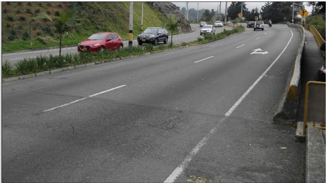
Ilustración 1. Viaducto V-13 PR10+335 de la Vía Las Palmas
