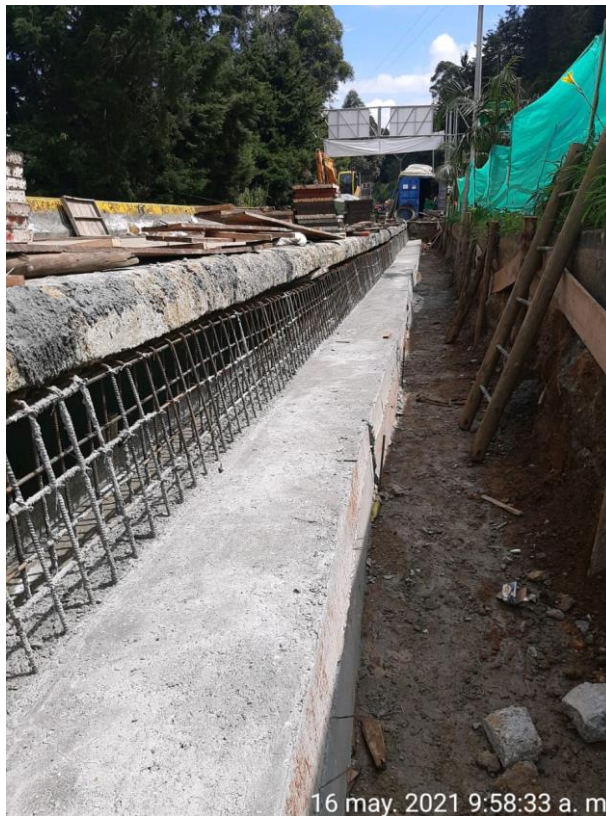
Ilustración 15. Muro de contención (zapata fundida y vástago próximo a fundir) realizados en el viaducto 13.
