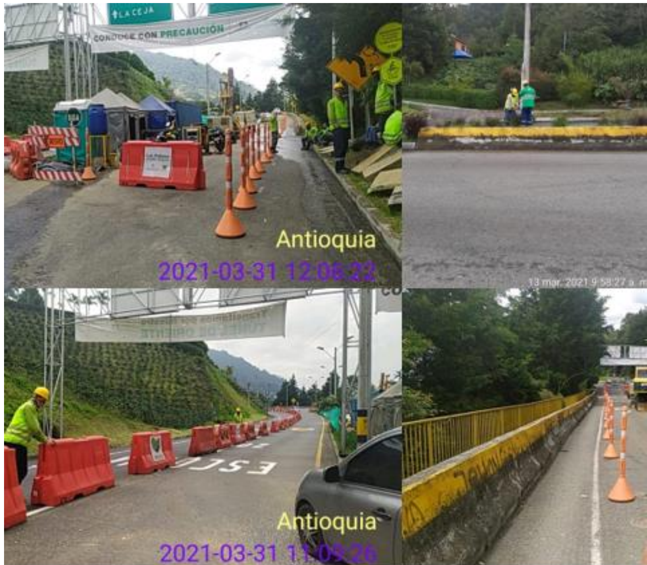
Ilustración 5. Cerramiento y señalización para inicio de actividades en el viaducto 13.
