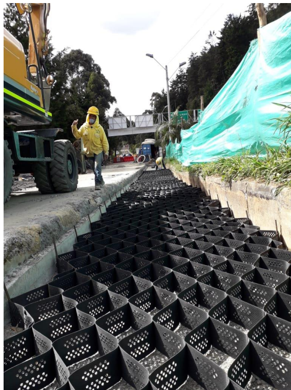
Ilustración 20. Instalación de geocelda en el viaducto 13
