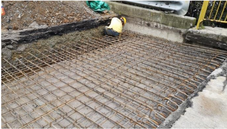
Ilustración 21. Instalación de refuerzo para losa de aproximación del viaducto 13.
