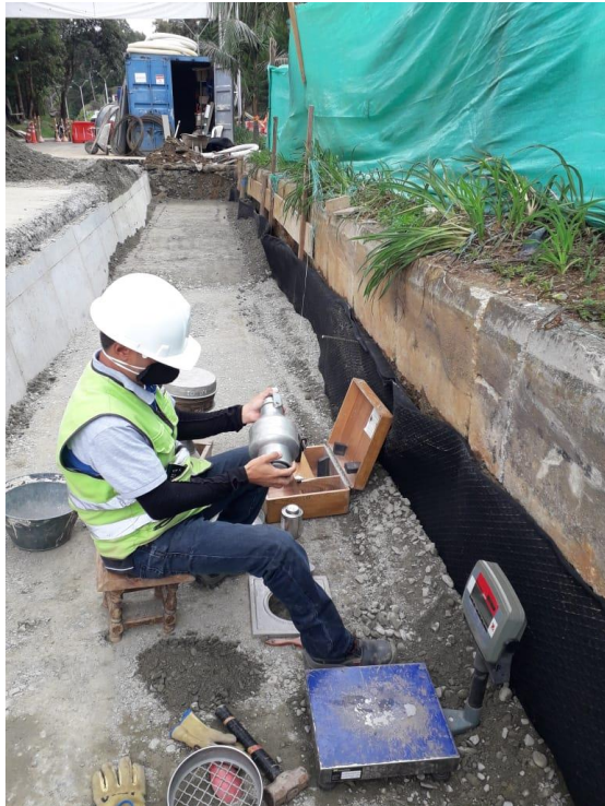
Ilustración 19. . Toma de densidades, para aceptación de colocación de base granular en el viaducto 13
