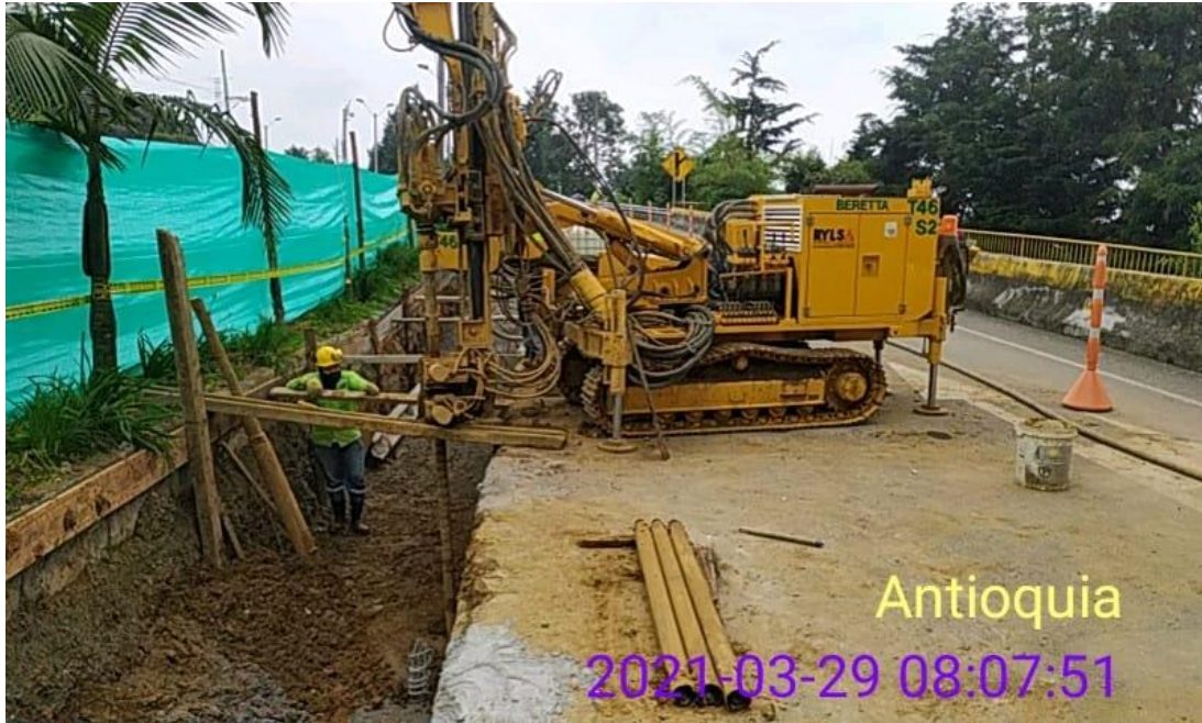
Ilustración 9. Perforación de micropilotes con BERETTA T46-S2 en el viaducto 13
