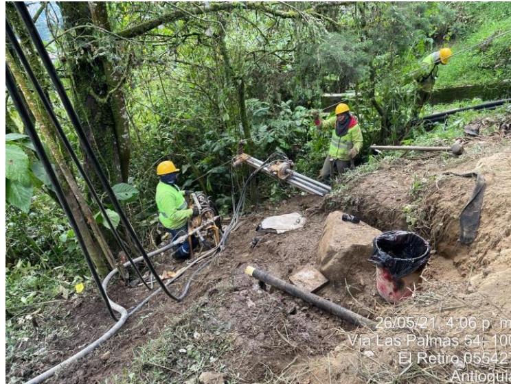
Ilustración 11. Perforación de drenes con BERETTA T-19 en el viaducto 13.
