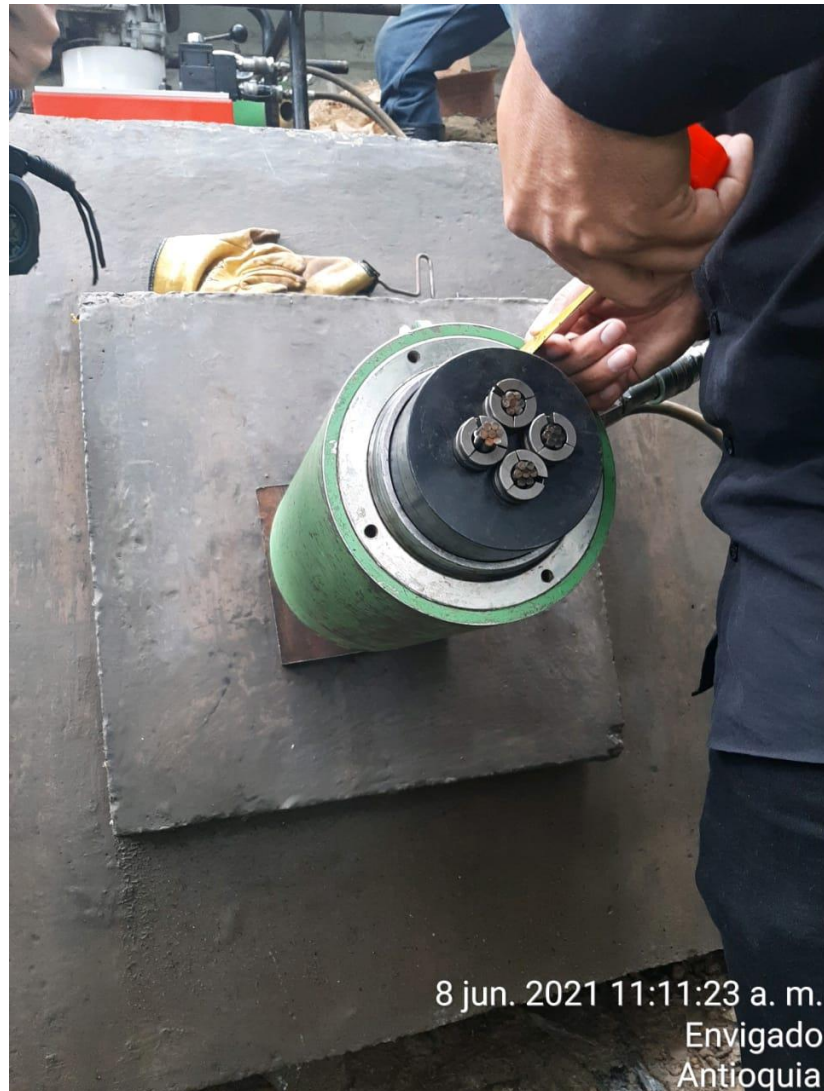
Ilustración 14. Tensionamiento de anclajes del viaducto 13.
