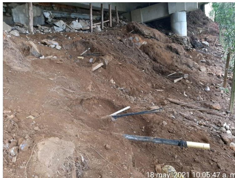
Ilustración 12. Drenes realizados con BERETTA T-19 en el viaducto 13.
