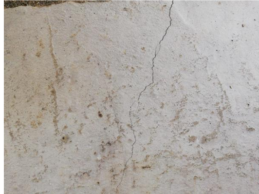
Figura 22. Losa de concreto reforzada con macro fibra de LDPE-R
